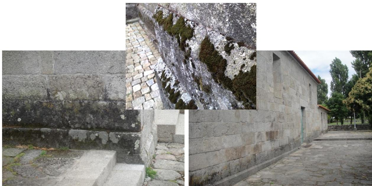
Figura 47 – Filmes negros provenientes da humidade e vegetação parasita na base das paredes da Igreja de Airões
