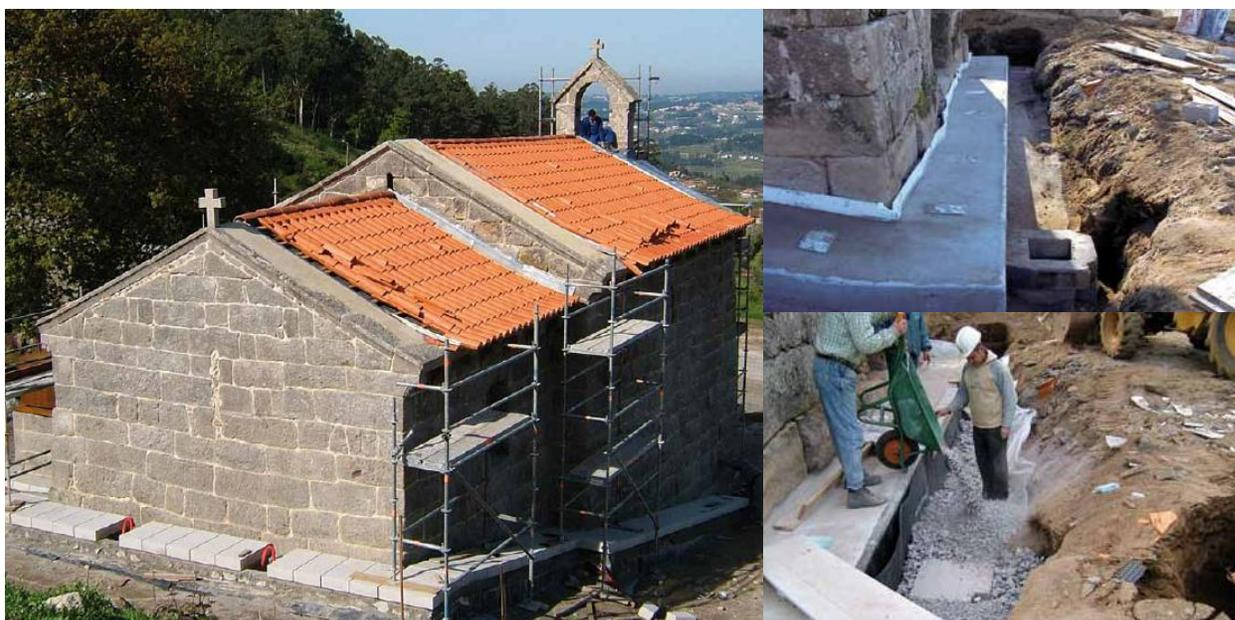
Figura 53 – Trabalhos de execução Caleira para ventilação dos pavimentos e drenagem das águas pluviais na Igreja de São Mamede Vila Verde.
