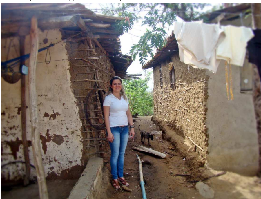
Fotografia 8 - Aspecto de construções de casas de taipas na Região do Nordeste brasileiro. Sobral, Ceará, dezembro, 2012. (Foto: Margareth Muniz)
