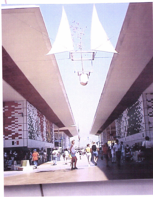
1- Aguirre, 1998, Instalação (cabos estrutura em aço, tecido, planta etc.) Lisboa Expo98
