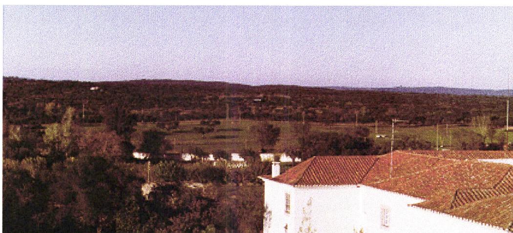
Figura 2.4 Aspecto do Ensaio 2 e da paisagem circundante em Dezembro de 1992. Destaca-se o muro da Horta que encobre a estrada para a povoação de Valverde. Em primeiro plano os telhados do Convento do Bom Jesus de Valverde também conhecido como Conventinho.
