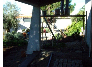
Fig. 30 – Vista sobre os cubos de granito inseridos no pavimento do alpendre
