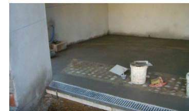
Fig. 31 – Vista sobre os cubos de granito inseridos no pavimento da garagem
