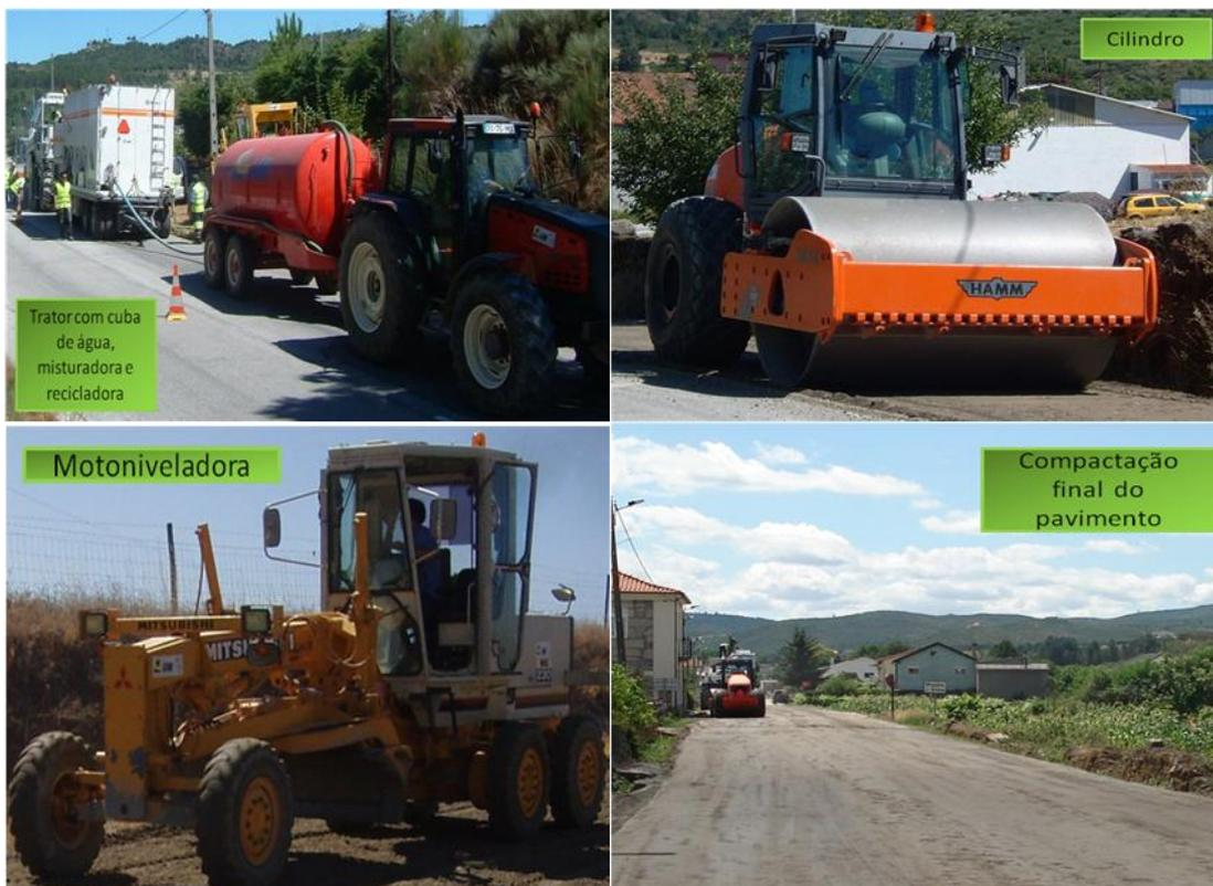
Figura n.º 15 - Processo construtivo – reciclagem *in situ* a frio
