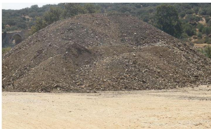
Figura n.º 5 - Material fresado em vazadouro para ser reutilizado e transportado para central
