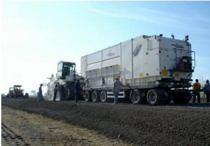
Figura n.º 35 - Misturadora WM 1000 acoplada à recicladora para a operação de reciclagem a frio in situ com incorporação de calda de cimento, Wirtgen Group <sup>11</sup>
