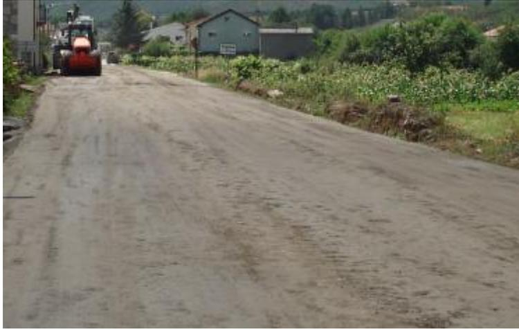
Figura n.º 6 - Reciclagem de pavimento rodoviário *in situ* com incorporação de material fresado a 100%
