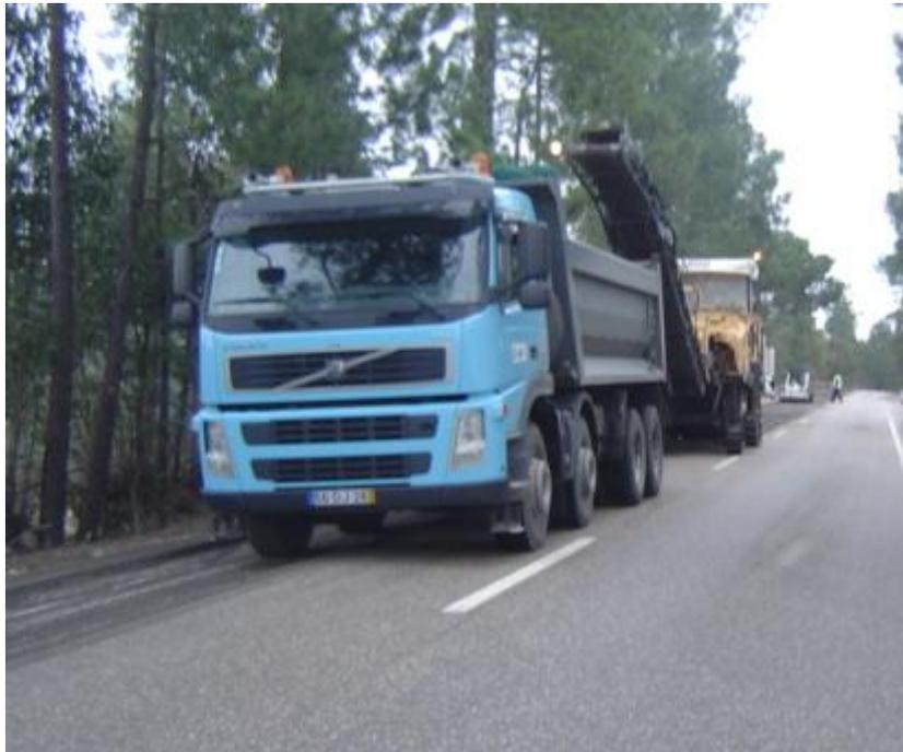
Figura n.º 27 - Transporte de material fresado
