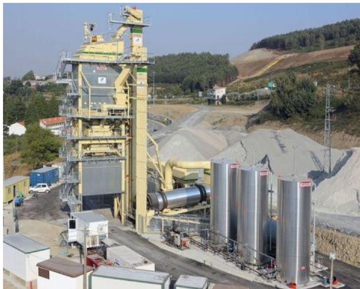
Figura n.º 2 - Central descontínua na produção de betão betuminoso (fig. RM-200 com torre dosificadora mezcladora INNOVA) <sup>2</sup>
