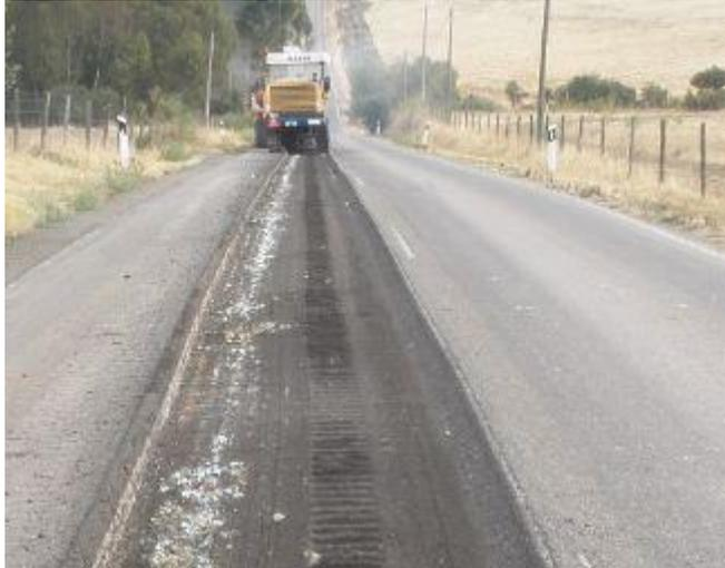
Figura n.º 4 - Fresagem do pavimento para prevenir a degradação, evitando, assim, a entrada em colapso do pavimento
