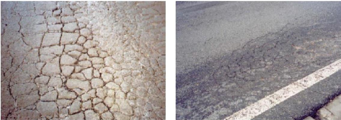
Figura n.º 11 - Fendilhamento do tipo pele de crocodilo (Ferreira, 2009)
