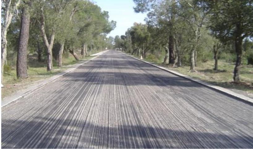
Figura n.º 28 - Pavimento fresado pronto para receber o novo pavimento
