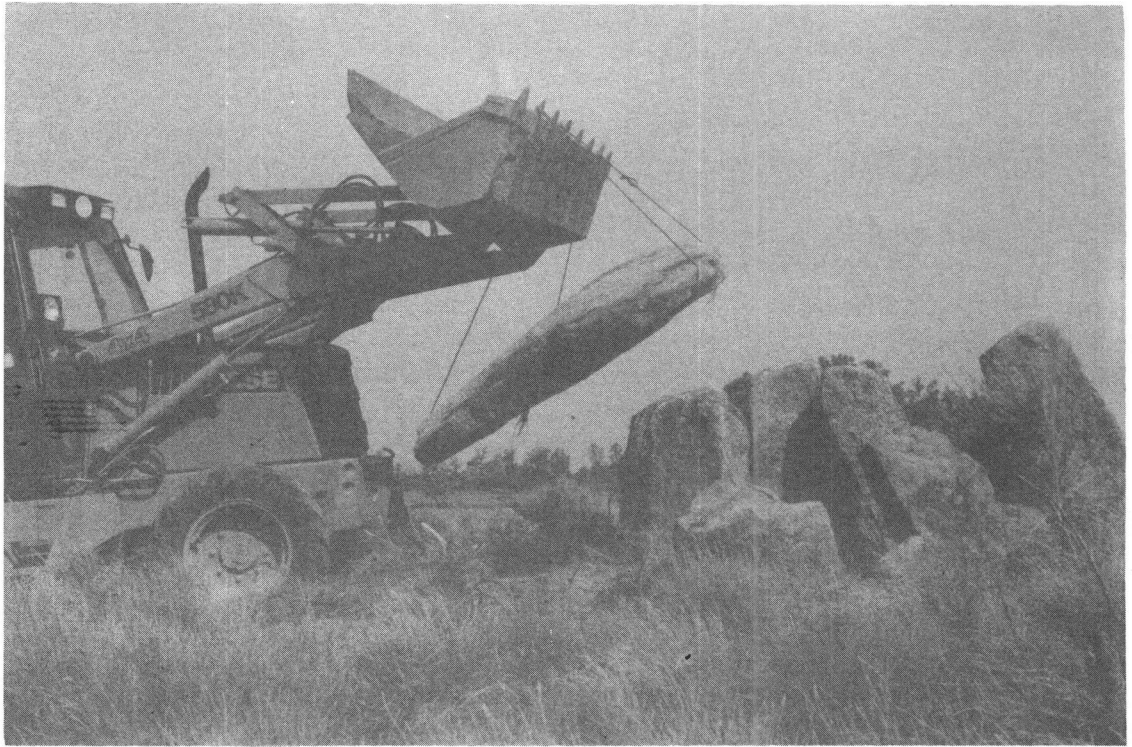
Anta do Sobral - recolocação da cobertura
