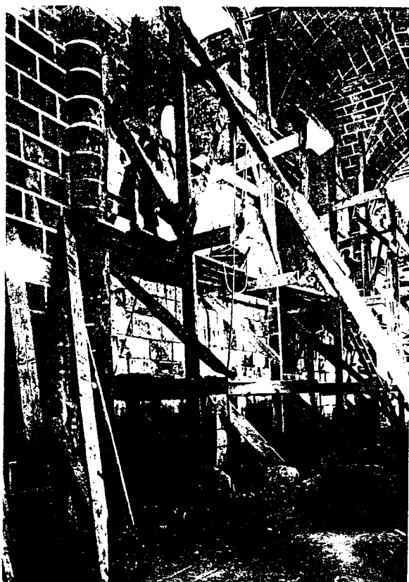
Fig.4.17. Um aspecto da demolição das capelas.
