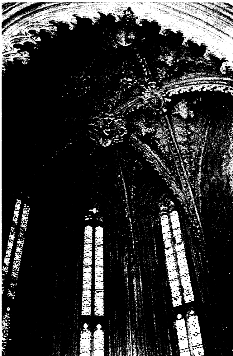
Fig.3.119. Abóbada estrelada no Mosteiro da Batalha.
