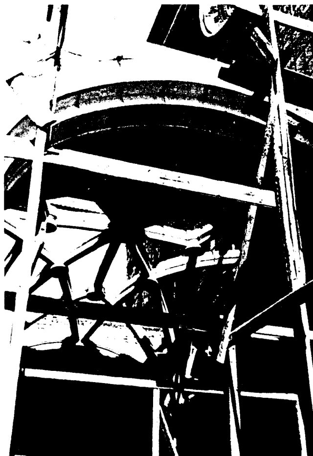
Fig.3.117. MOSTEIRO DOS JERÓNIMOS Lançamento das ogivas da abóbada de cruzaria de ogivas, na época em que foi acrescentado o pórtilco de acesso à igreja e claustro do mosteiro, já neste século.
