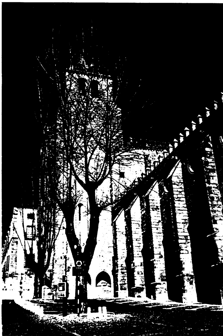
Fig.4.14. Parede exterior do claustro, onde estiveram adossadas, as vestiarias.
