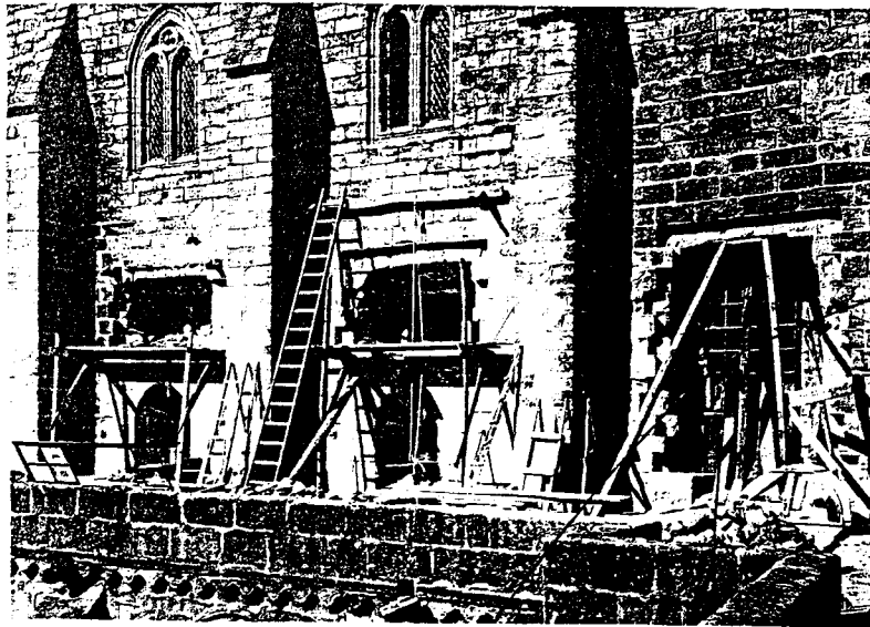
Fig.4.19. Demolição das janelas coevas das capelas laterais.
