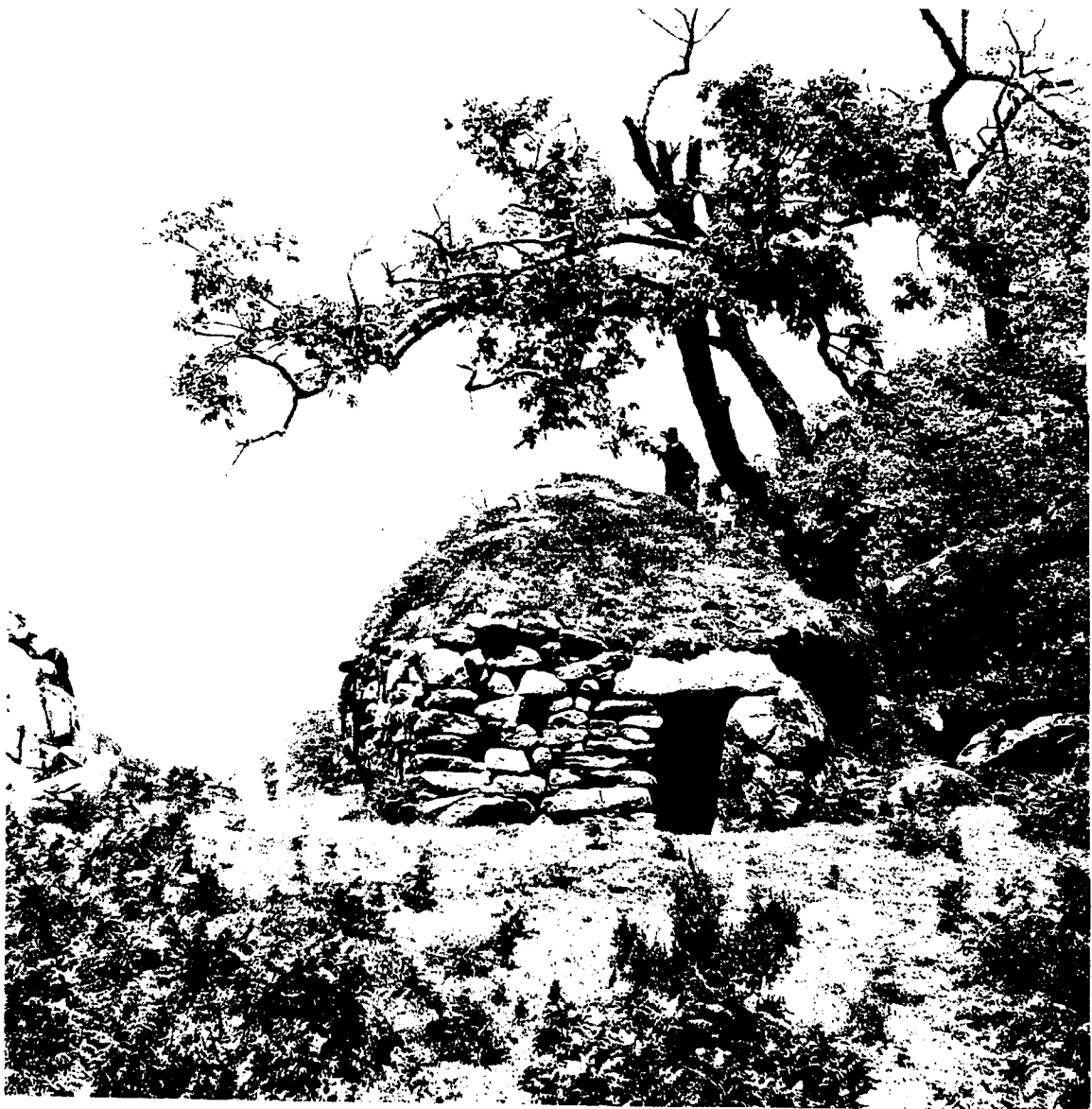
Fig.3.6. Um forno, exemplo de uma construção primitiva, que pode encontrar-se na Serra do Gerês.
