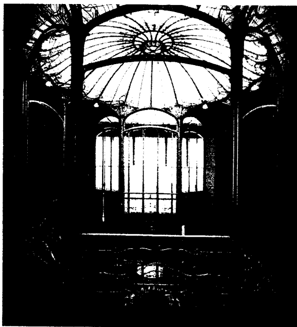
Fig.3.46. VICTOR HORTA CASA VON EETVELDE - Bruxelas. Cúpula de arco abatido em vidro.
