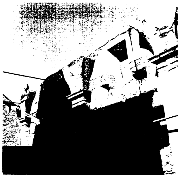
Fig.4.24. Arranque das abóbadas.
