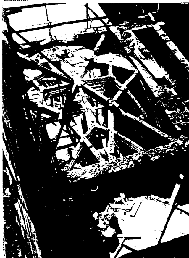
Fig.3.118. MOSTEIRO DOS JERÓNIMOS Aspecto das ogivas da abóbada aquando da sua construção.
