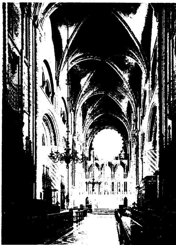
Fig.3.23. CATEDRAL DE DURHAM Cobertura em abóbada de cruzaria de ogivas, talvez o exemplo mais antigo de que há notícia.
