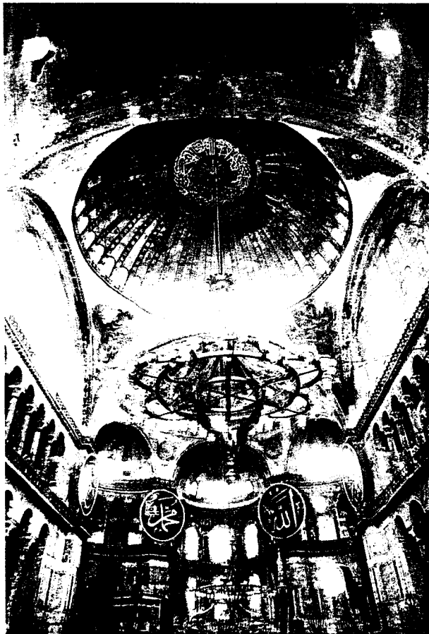
Fig.3.67. Aspecto do interior da enorme cúpula de S.Sofia, repousando em triângulos esféricos.
