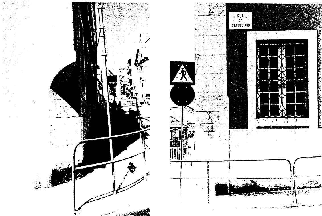
Fig.3.150. Dois aspectos de uma trompa cilíndrica em ângulo na Rua do Patrocínio, Lisboa.
