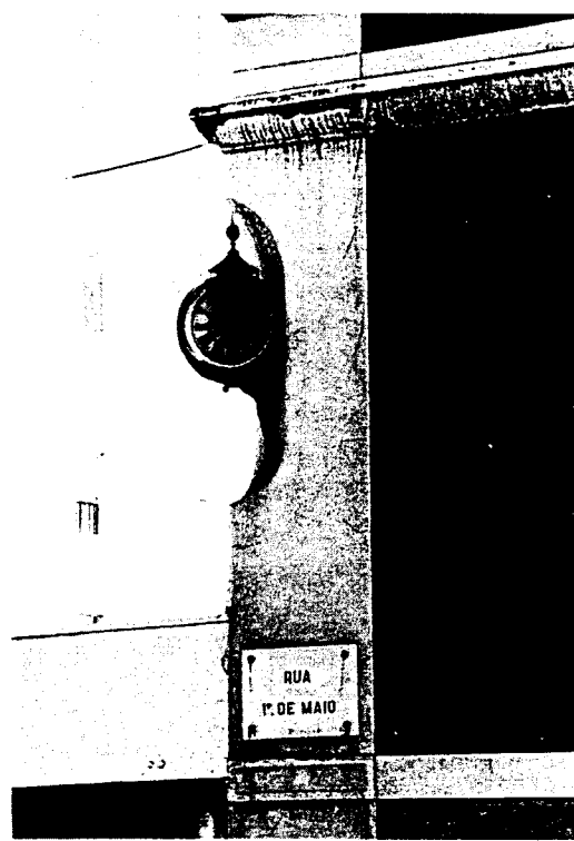
Fig.3.146. Trompa cilíndrica em ângulo, na Rua 1º de Maio, Lisboa.
