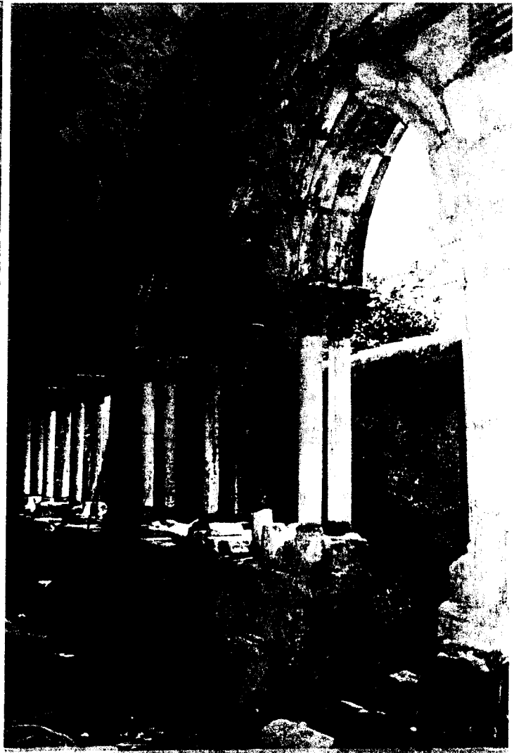
Fig.4.45. Arcos do claustro, apresentando uma inclinação que faz prever a sua ruína.
