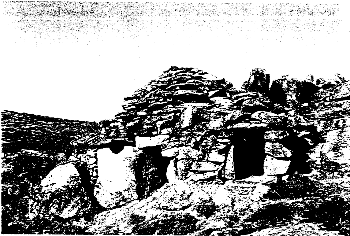
Fig.3.3. Branda ou abrigo , na Serra do Soajo.
