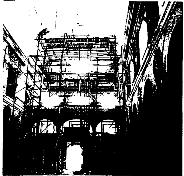
Fig.4.28. Interior da Igreja da Graça , em obras.
