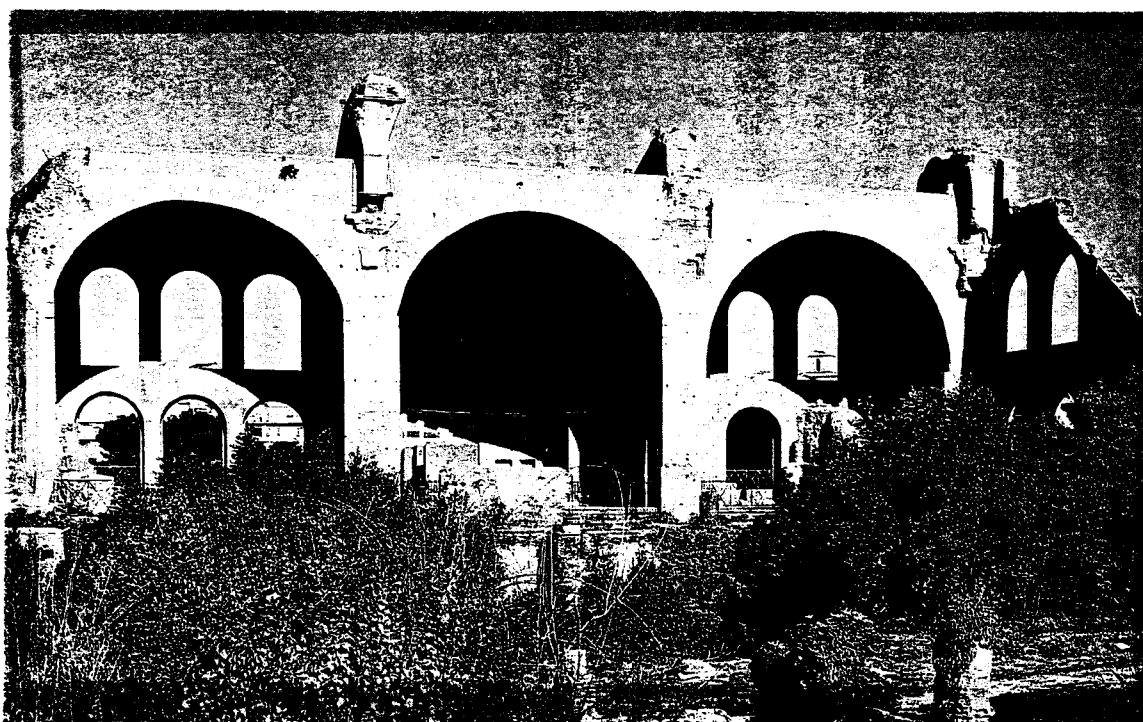
Fig.3.13. BASÍLICA DE MAXÊNCIO Construída entre 308 e 312, dela se podem observar, as enormes abóbadas de berço com caixões no seu intradorso.
