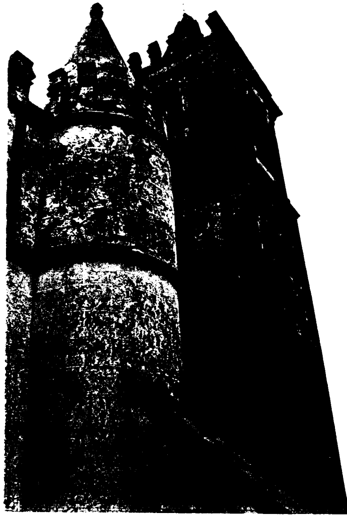
Fig.4.61. Torre sineira e torre que coroa o cumhal da Igreja, com aspecto muito degradado.
