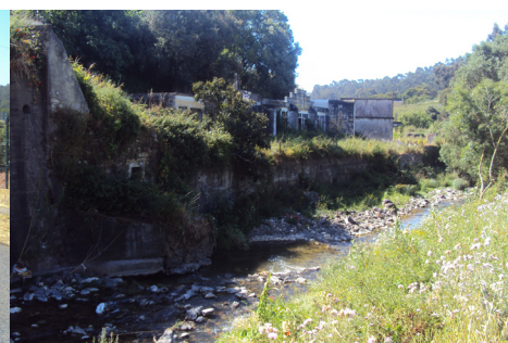
FIG. 97 - DELIMITAÇÃO DA RIBEIRA ATRAVÉS DE MURUS DE PEDRA OU BETÃO
