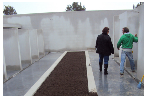
FIG. 206 - ÁREA DE "BOXES" COM CANTEIRO
