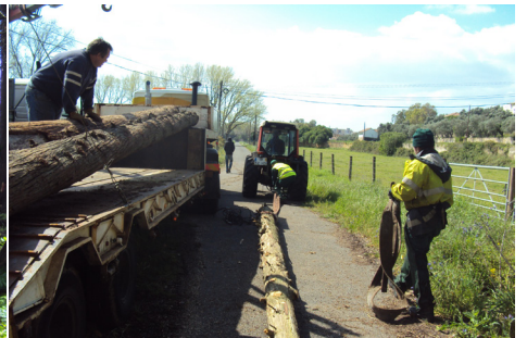
FIG. 272 - TRANSFERÊNCIA DOS TRONCOS PARA O VEÍCULO DE TRANSPORTE
