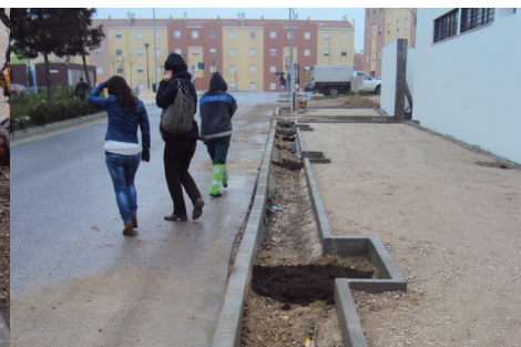
FIG. 208 - ENCHIMENTO DAS COVAS PARA PLANTAÇÃO ARBÓREA
