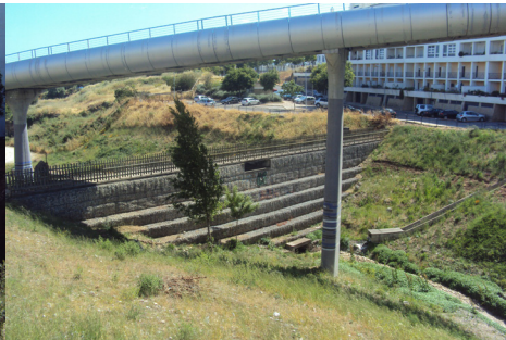
FIG. 89 - PAREDE DE GABIÕES NO ATRAVESSAMENTO DA LINHA DO SATUD
