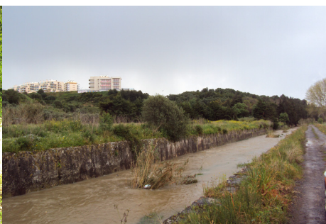
FIG. 67 - RIBEIRA A SUL DA ESTAÇÃO AGRONÓMICA NACIONAL
