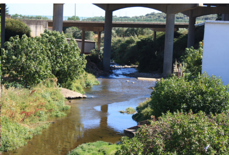
FIG. 64 - INÍCIO DO SEGUNDO TROÇO DA RIBEIRA DA LAJE
