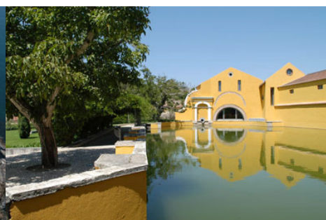
FIG. 3 - FÁBRICA DA PÓLVORA, BARCARENA
