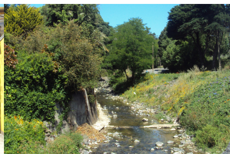
FIG. 100 - VISTA PARA A RIBEIRA DA PONTE DA QUINTA DO MONTE, EM BARCARENA
