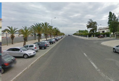
FIG. 146 - PASSEIO MARÍTIMO DE ALGÉS, TROÇO DE ACESSO À DOCA DE PEDROUÇOS
