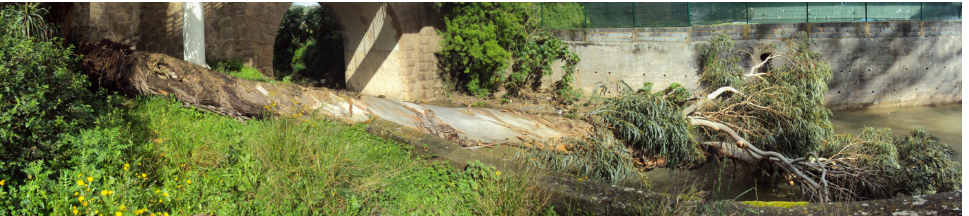
FIG. 229 - PANORÂMICA DO LOCAL DE INTERVENÇÃO
