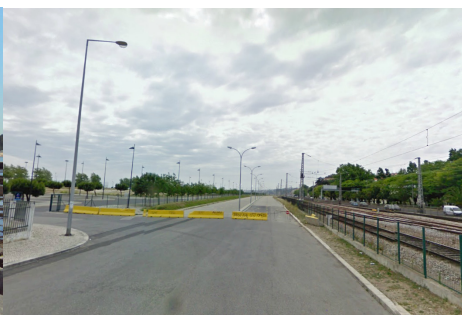
FIG. 143 - PASSEIO MARÍTIMO DE ALGÉS, TROÇO DO JARDIM DE ALGÉS
