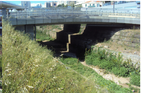
FIG. 90 - PASSAGEM PEDONAL PARA O CENTRO HISTÓRICO DE PAÇO DE ARCOS
