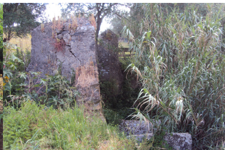
FIG. 112 - APROVEITAMENTO DE UM VELHO MOINHO EXISTENTE NO LOCAL
