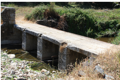
FIG. 63 - PONTE DE PEDRA DA RIBEIRA DA LAJE, NA FREGUESIA DE PORTO SALVO
