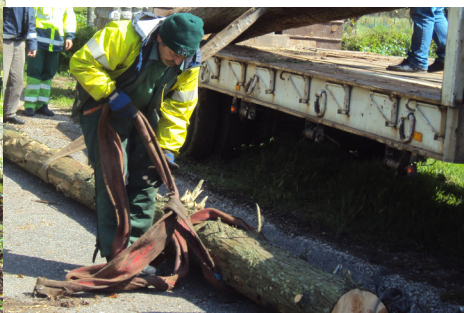
FIG. 273 - PORMENOR DA APLICAÇÃO DE GINTAS PARA ELEVÇÃO COM GRUA
