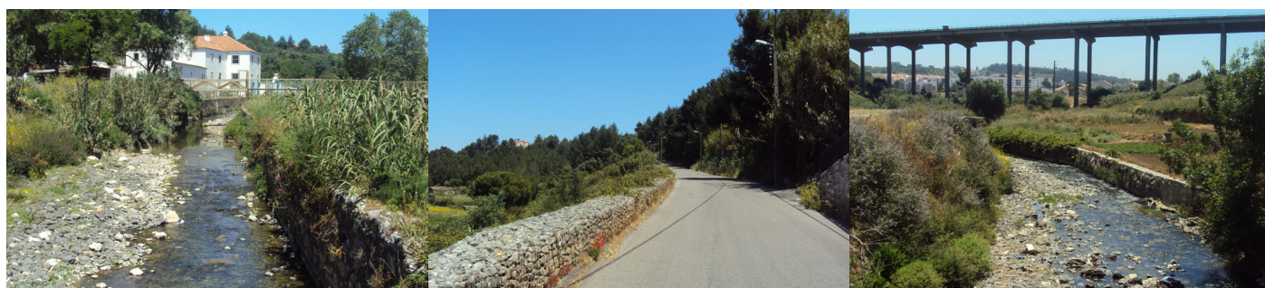
FIG. 101 - PONTE DA RUA ANTERO DE QUINTAL, EM BARCARENA FIG. 102 - ESTRADA DO CACÉM, PARA ONDE SE PROPÕE UMA CICLOVIA PARALELA À RIBEIRA DE BARCARENA FIG. 103 - RIBEIRA DE BARCARENA NO ATRAVESSAMENTO DA A5
