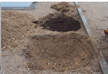
FIG. 207 - ABERTURA DE COVAS PARA ÁRVORES DE ARRUAMENTO
