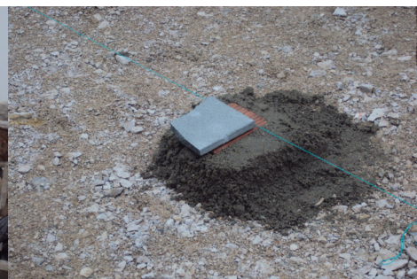
FIG. 205 - PORMENOR DE IMPLANTAÇÃO DE PAVIMENTO
