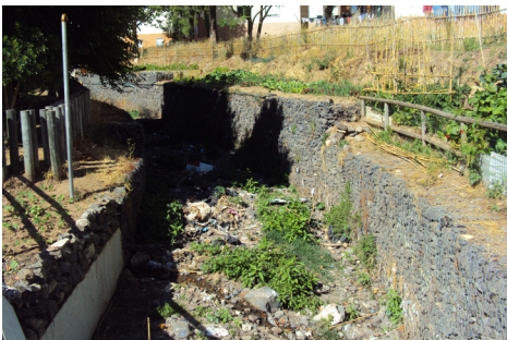
FIG. 133 - TROÇO DA RIBEIRA QUE FOI ALVO DE REQUALIFICAÇÃO
