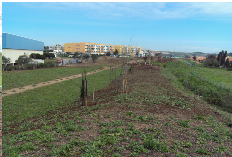
FIG. 220 - ESTADO INICIAL DO LOCAL DE INTERVENÇÃO, VISTA PARA NORTE
