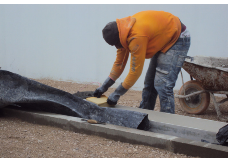
FIG. 204 - CONSTRUÇÃO DOS MUROS
