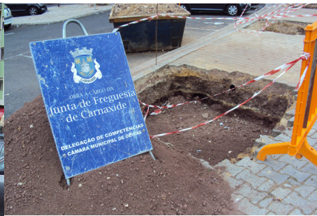
FIG. 263 - PORMENOR DE SINALIZAÇÃO ATRAVÉS DE PLACA DE OBRA
