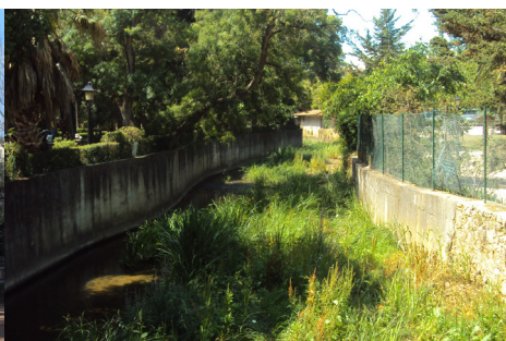
FIG. 70 - RIBEIRA NO TROÇO CORRESPONDENTE AO PARQUE URBANO DE Oeiras
