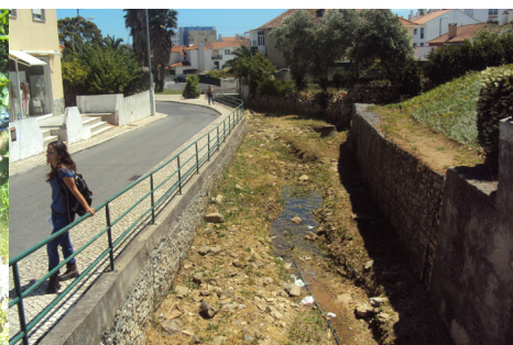
FIG. 80 - RIBEIRA DE PORTO SALVO AO LONGO DA RUA GENERAL HUMBERTO DELGADO
