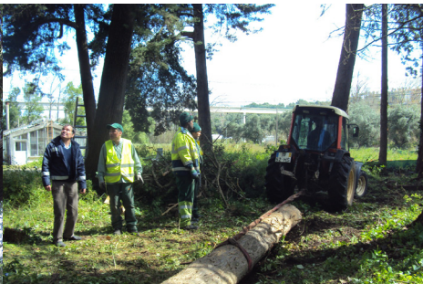
FIG. 271 - REBOQUE DOS TRONCOS APÓS ABATE
