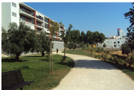
FIG. 197 - OBRA CONCLUÍDA, VISTA NORTE-SUL
