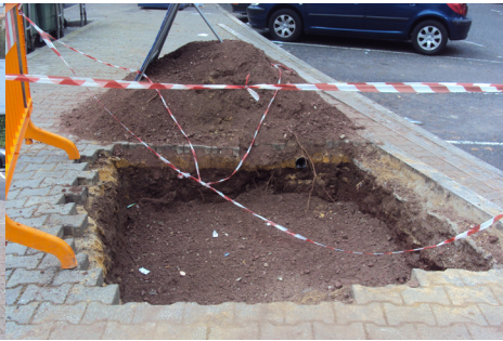
FIG. 260 - COLOCAÇÃO DAS TERRAS APROPRIADAS
