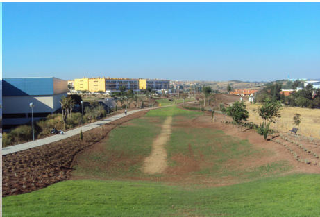
FIG. 222 - ASPETO FINAL DA INTERVENÇÃO, VISTA PARA NORTE
