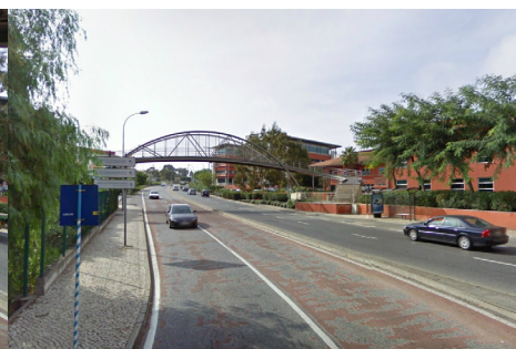
FIG. 40 - ROTUNDA DE INTERLIGAÇÃO DA AVENIDA DO CONSELHO EUROPEU COM A ESTRADA DE PAÇO DE ARCOS, N249-3
