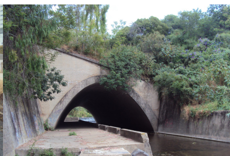
FIG. 121 - TÚNEL QUE FAZ O ATRAVESSAMENTO DO RIO JAMOR PELA A5
