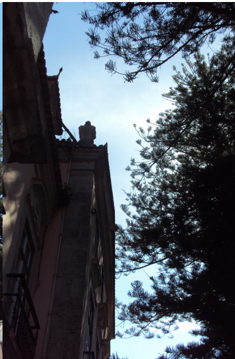
FIG. 308 - PROXIMIDADE AO EDIFÍCIO
