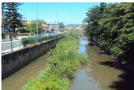
FIG. 107 - VISTA PARA A RIBEIRA DE BARCARENA NA PONTE DE ACESSO À QUINTA REAL DE CAXIAS
