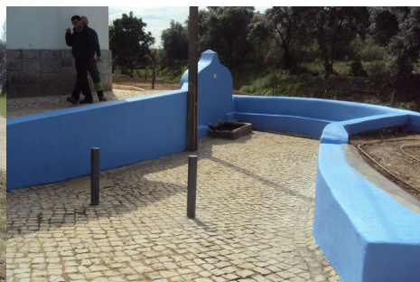
FIG. 196 - LAVADOURO, APÓS RECUPERAÇÃO
