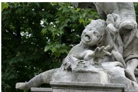
**Figura 8** - Estátua danificada pela ação das chuvas ácidas.
