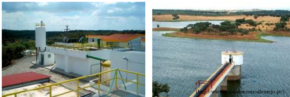
Figura 3 – Obra de captação de água de Monte Novo.
