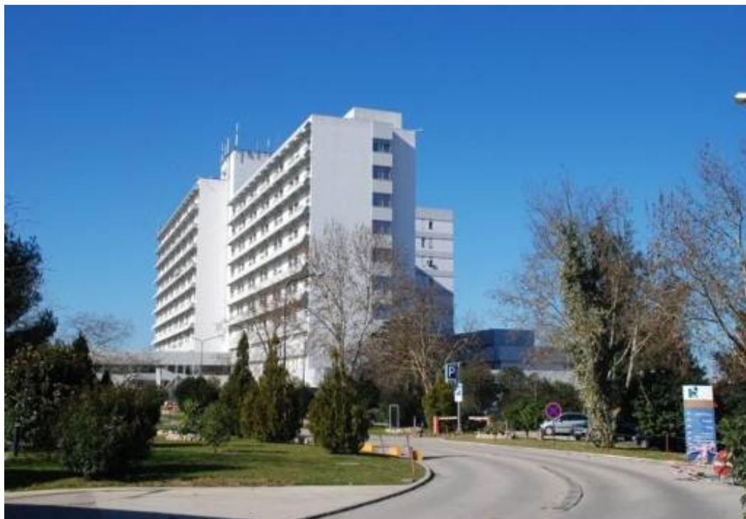
Figura 2: Hospital Distrital de Santarém
