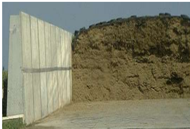
Fig. 45 – Silos horizontais com paredes laterais em betão
