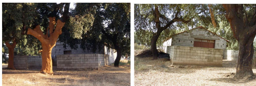
Figura 3.26 - Alojamento sujeito a obras de ampliação da porta principal.
