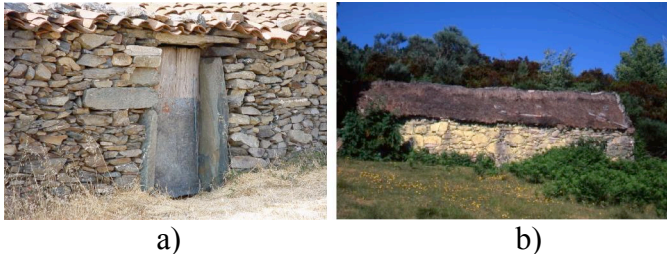
Figura 3.28 - Alojamentos com cobertura de telha de barro (a) e cobertura vegetal (b).
