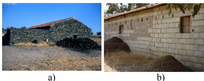
Figura 3.29 - Janela do estrume presente em construções antigas (a) e recentes (b).
