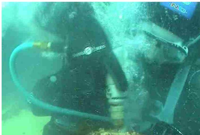
Perfuração da rocha-mãe para instalação de um marcador topográfico (*spit*).
