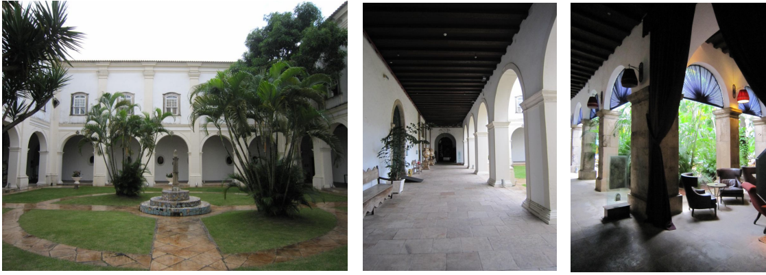
Figs. 46, 47 e 48. Convento de Nossa Senhora do Carmo. Vistas do claustro do convento.
