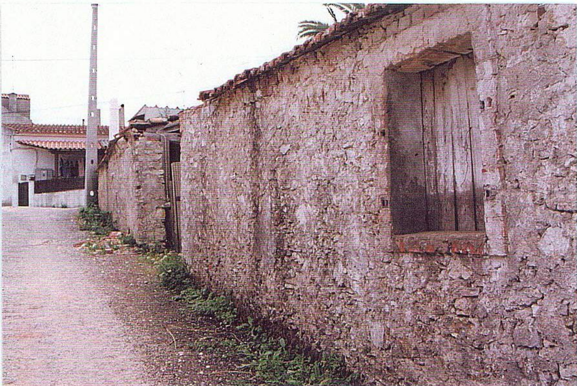
Fig. 10 – Póvoa de Cós, Vista do alçado Norte do conjunto.
