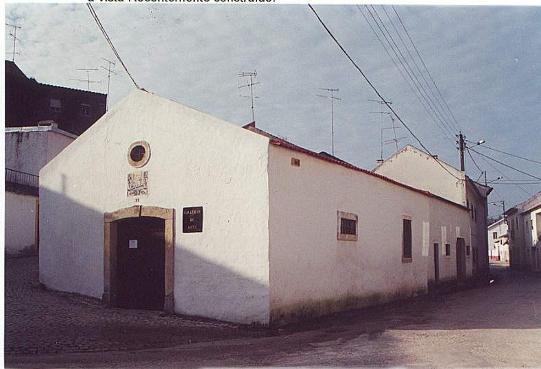
Fig. 7 – Cós, vista global do antigo edifício da adega.
