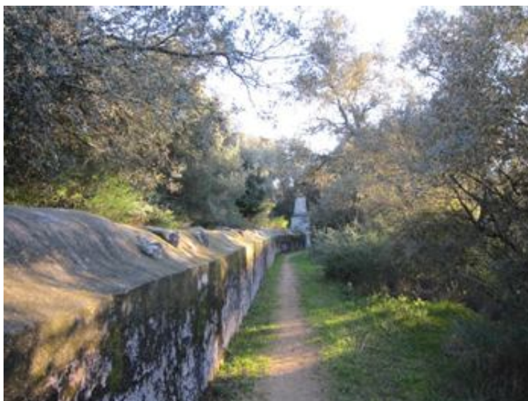
Fig. 38 – Vista do troço de aqueduto e respectivo respiradouro, na Quinta de Sam Pedro.
