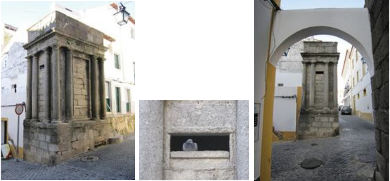
Figs. 3, 4 e 5 – Vistas da caixa de água da Rua Nova. Alçados principal e lateral da caixa de água.
