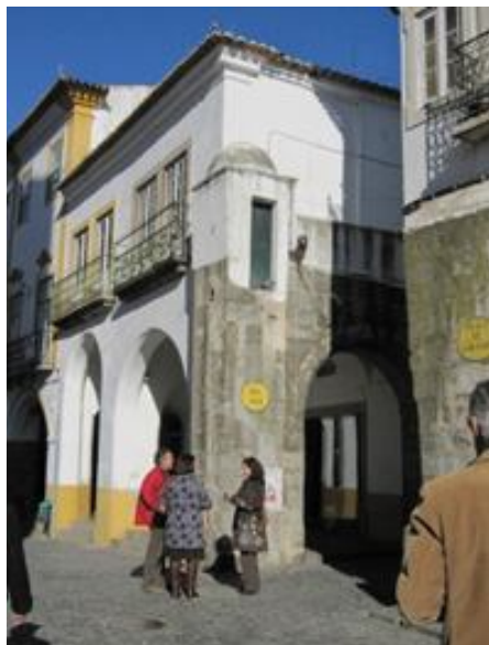
Fig. 6 - Vista da Caixa de Água da Rua Nova.
