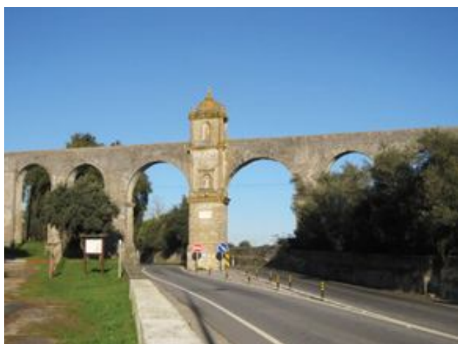
Fig. 1 – Vista do Aqueduto na Estrada para Arraiolos.
