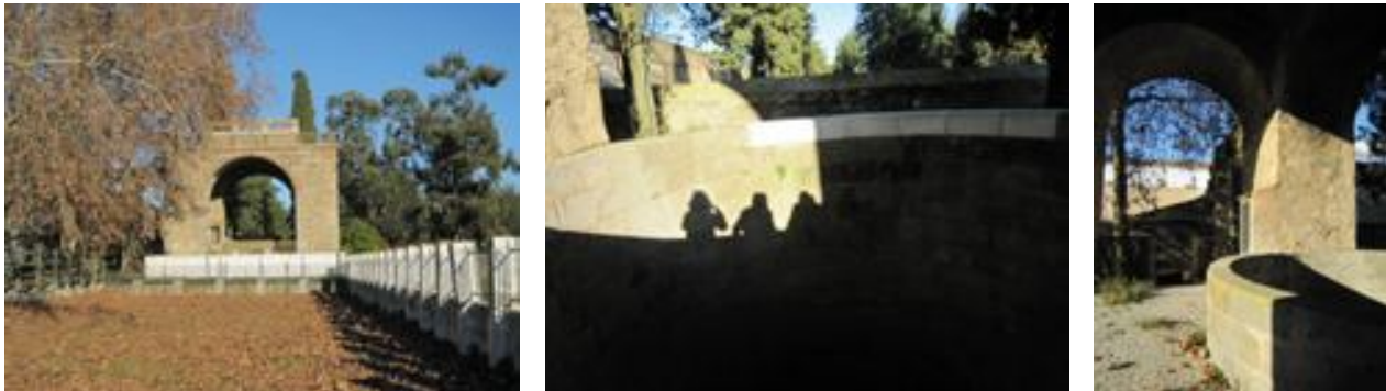
Figs. 28, 28 e 30 – Vistas da nora e imenso poço construído em alvenaria de granito no século XVI.
