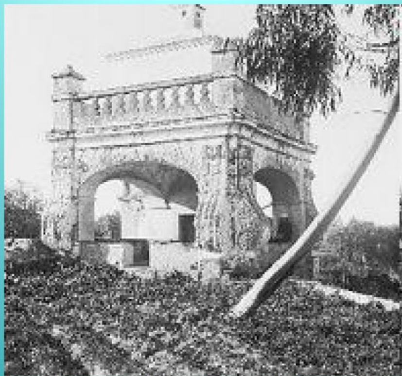
Caixa de água do Convento da Cartuxa - Inácio Caldeira – Cerca de 1920 - Cota CME0325 - Propriedade Arquivo Fotográfico CME
