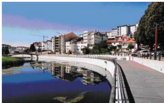
FIG 1 Requalificação do rio Fervença em Bragança
