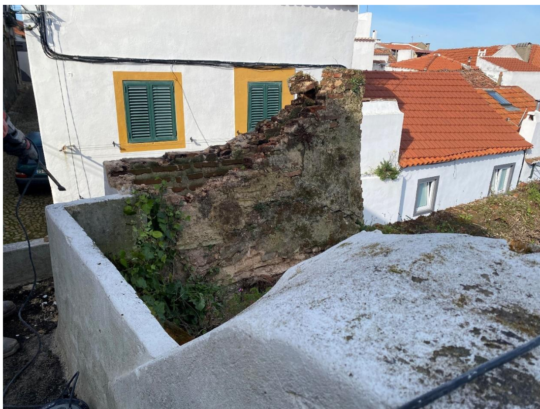
(Figura 91 – Acompanhamento na desmontagem da chaminé; Fonte: Rafael Matos)
