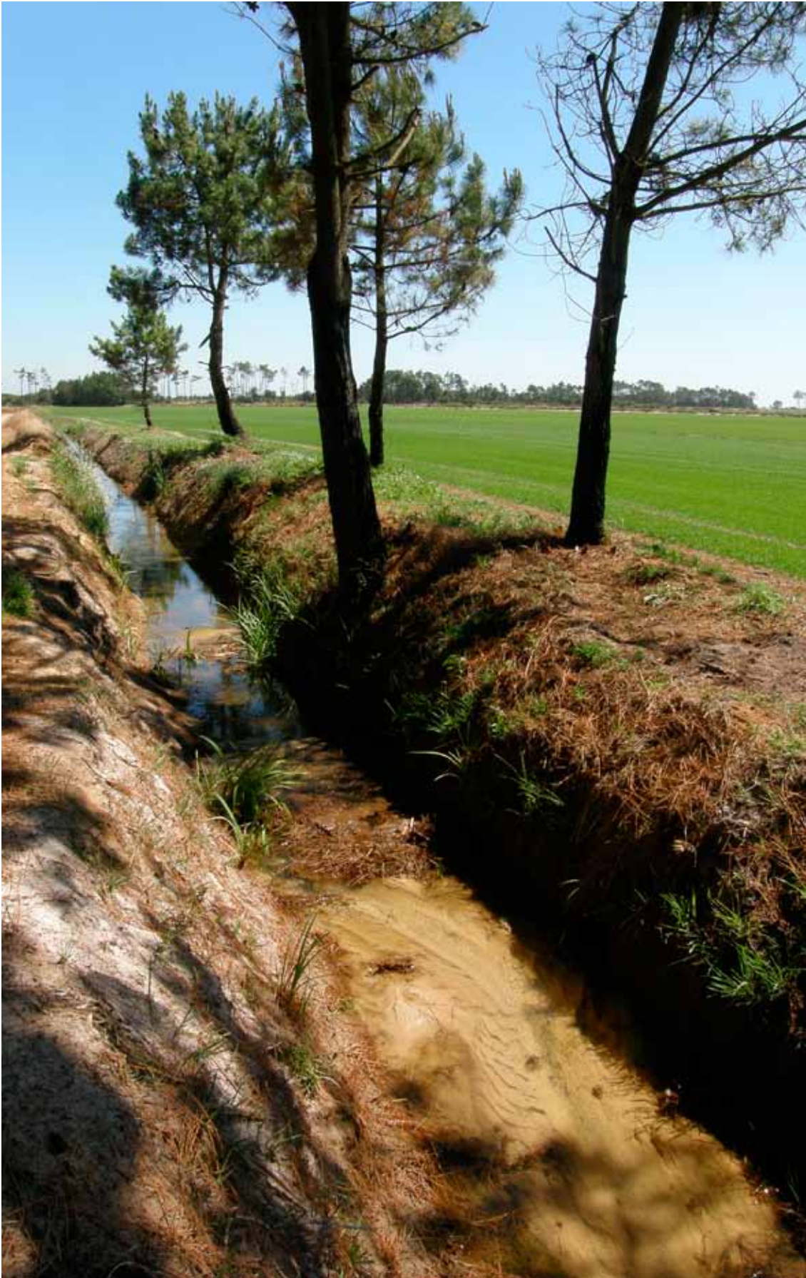
Figura 13. Nivelamento de terreno e valas de drenagem em parcelas onde existiram, no passado, charcos temporários.
