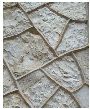
Figura 107. Detalhe do revestimento em pedra das fachadas a poente e a no
