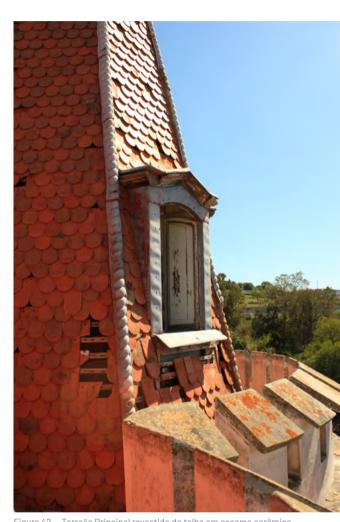
Figura 42. Torreão Principal revestido de telha em escama cerâmica
