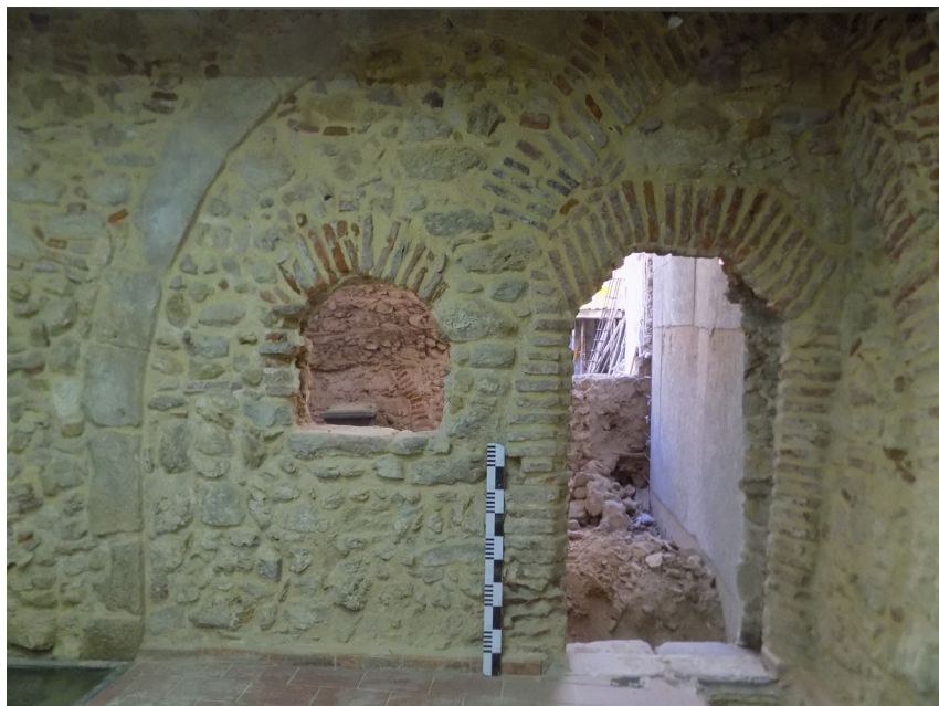
Figura 3 – Janela e vão (Compartimento VIa) de acesso ao compartimento central.
