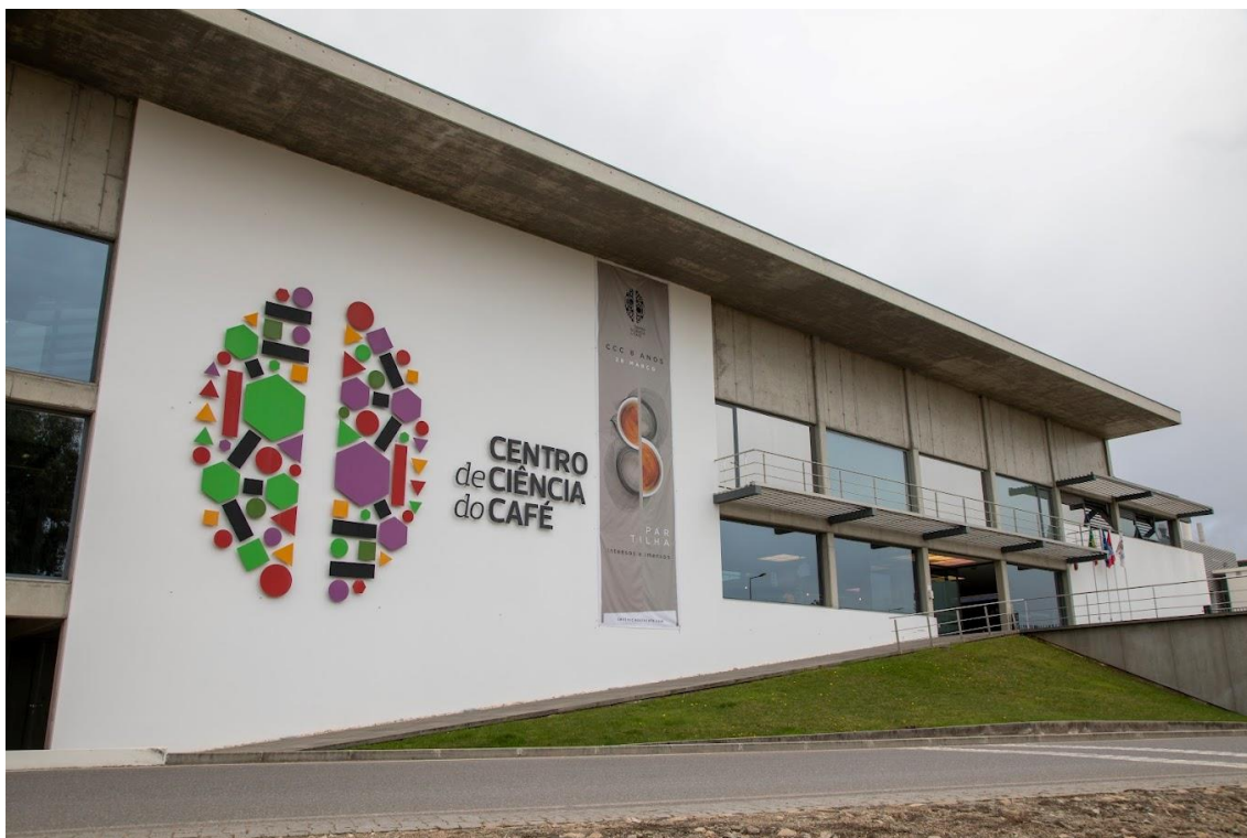
Figura 33 – Edifício do Centro de Ciência do Café Fonte: Centro de Ciência do Café
