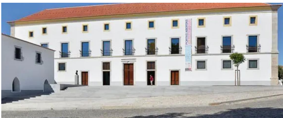
Figura 29 – Edifício do Centro de Arte e Cultura da Fundação Eugénio de Almeida
