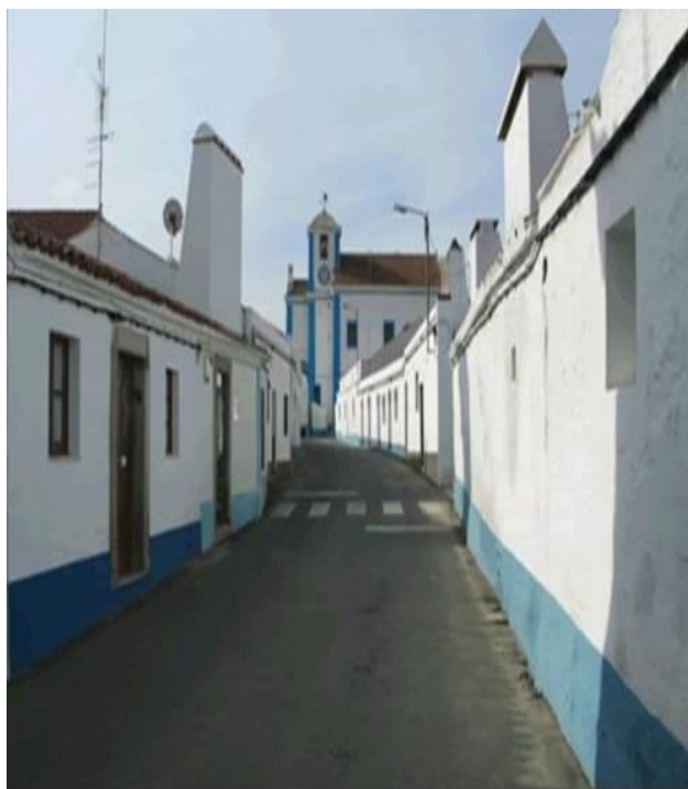
Figura 23 – Edifício Sede da Suão
