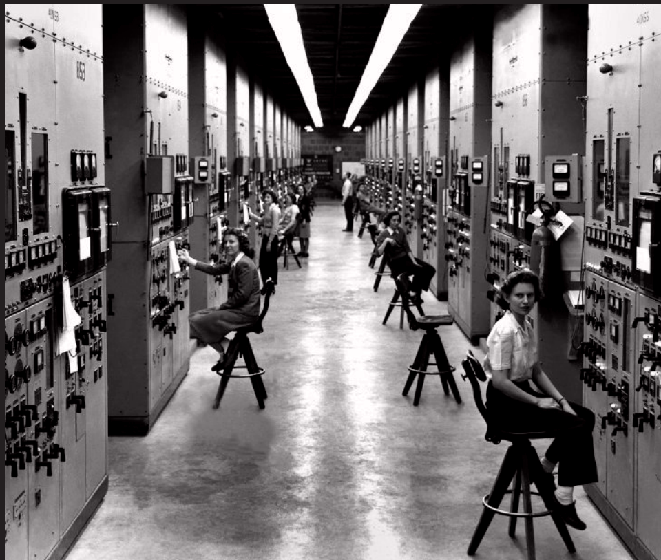
Fig. 8 – Mulheres operadoras de Calutron na fábrica Y-12 em Oak Ridge, Tennessee, Estados Unidos, durante a 2.ª Guerra Mundial. Os calutrons eram equipamentos que serviam como espectrômetro de massa, usado no processo de separação de isótopos de urânio. Durante o Projeto Manhattan para a construção do explosivo atômico, os técnicos trabalharam em segredo, sem ter a ideia do objectivo final do seu trabalho. Gladys Owens, a mulher sentada em primeiro plano, não percebeu o que estava a fazer até ao momento em que numa visita pública às instalações, cinquenta anos depois foi confrontada com a fotografia. Tennessee, EUA. Foto: Galerie Bilderwelt / Getty Images https://time.com/5191480/atomic-city-womens-history/ https://www.digitaltrends.com/cool-tech/women-scientists-of-the-manhattan-project-part-2/
