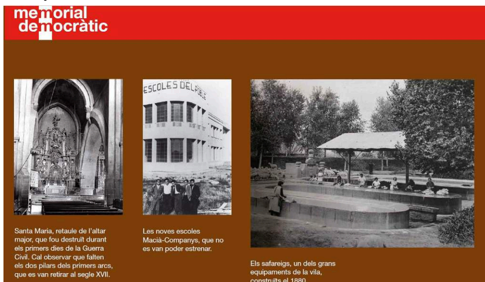
Fig. 3 – Detalle de uno de los paneles de señalización en Agramunt (Urgell), que describe gráficamente la situación de la población el año 1936.
