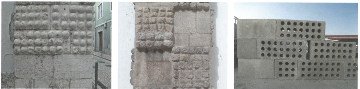
2.3.12. Esquerda: cunhal das Bolas – Bairro Alto, Lisboa; centro: pilastra da Igreja e Convento de Nossa Senhora da Graça – Torres Vedras; direita: tijolo industrial furado nos Banhos Islâmicos de Loulé – Fábrica de Blocos de São Brás de Alportel, Algarve. (fotografias: arquivo vmsa)
