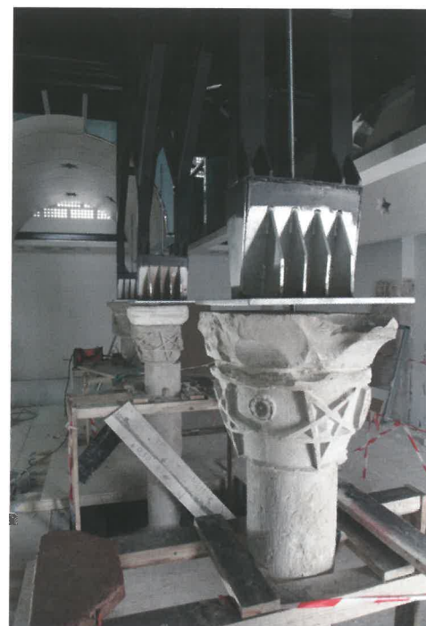
2.3.9. Estrutura metálica para suspensão dos arcos de alvenaria de modo a evitar carga sobre as colunas da casa dos Barretos. (fotografia: arquivo vmsa)
