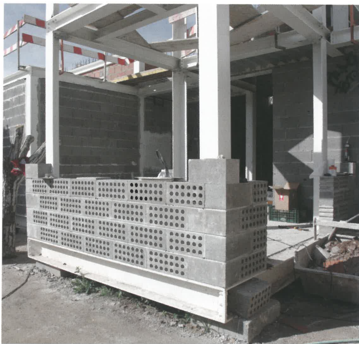
2.3.8. Estrutura metálica autonomizada do chão arqueológico, reversível. Projecto de estruturas: Eng. João Appleton e Pedro Ribeiro (A2P). (fotografia: arquivo vmsa)
