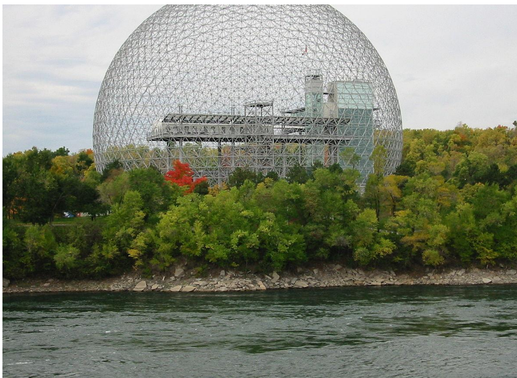
Figura 6 - Pavilhão norte-americano da Exposição Mundial de 1967 (na Ilha de Santa Helena, Montreal, Quebec, Canadá) projetada por R. Buckminster Fuller. Hoje em dia, designada de "Biosfera", é uma aplicação exemplar da estrutura designada por cúpula geodésica, segundo o conceito desenvolvido por Fuller, no âmbito do seu pensamento "sinérgico" (Wikipedia: https://pt.m.wikipedia.org/wiki/Buckminster_Fuller , 2023).
