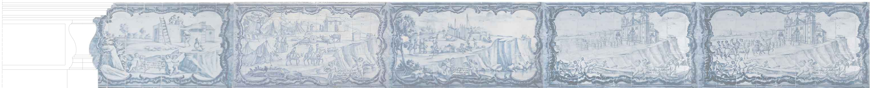
Fig. 89. Representa a edificação de um templo em que se vê homens trabalhando na construção das paredes já elevadas.
