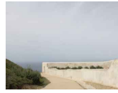
Fig. 229. Muro da Casa da Horte da Casa da Água. Fotografia do Autor, 2022.
