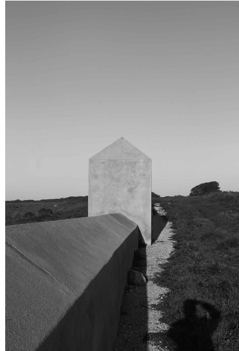
Fig. 226. Primeira fase do aqueduto. Fotografia do autor, 2023.
