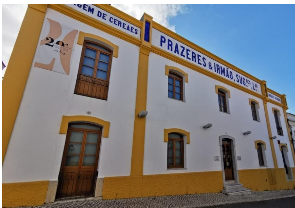
Figura 1.2: Instalações do CRBA em Castro Verde
