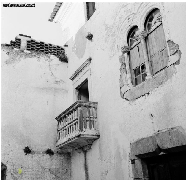
Fig.1 Casa Alcaide-mor de Estremoz em 1967 ©SIPA
