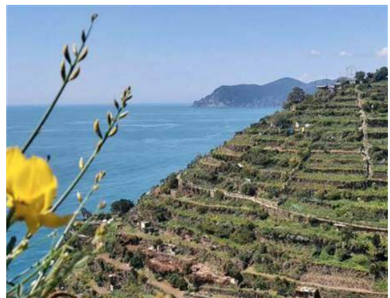
Image 47: Terrasses en Manarola réalisées avec murs en pierre sèche dite "Amphithéâtre des Géants", https://www.cittadellaspezia.com/2023/05/07/muri-a-secco-nuova-procedura-per-la-richiesta-di-materiale-lapideo-495035/ consulté le 15/08/2023
