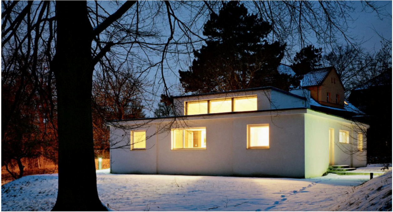
4 Frente de la casa Haus am Horn, materiales vistos, fachadas blancas y lisas, cubiertas planas y figuras simples. Es interesante el contraste que podemos observar por detrás, con una casa típica de la zona con el uso aparente de tejas y techos inclinados típicos de la zona por las condiciones climáticas, como la nieve que se refleja en la imagen.
