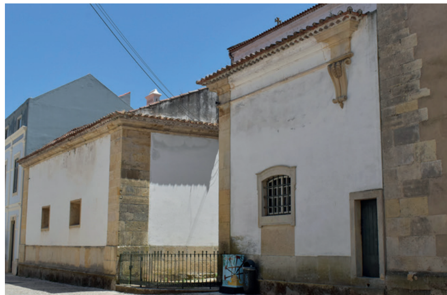
Img. 97-Fachada Norte da Igreja de S. João.
