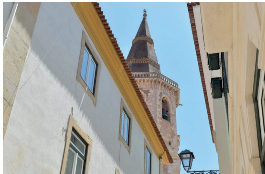
Img. 100-Vista da cúpula da torre sineira da Igreja de S. João.
