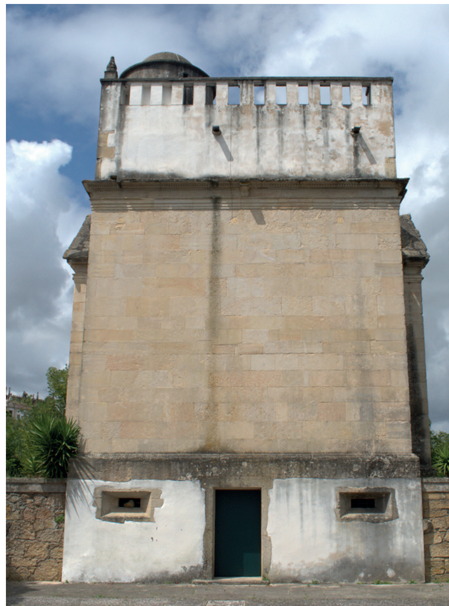
Img. 58-Fachada posterior da Ermida de N. Sra. da Conceição.
