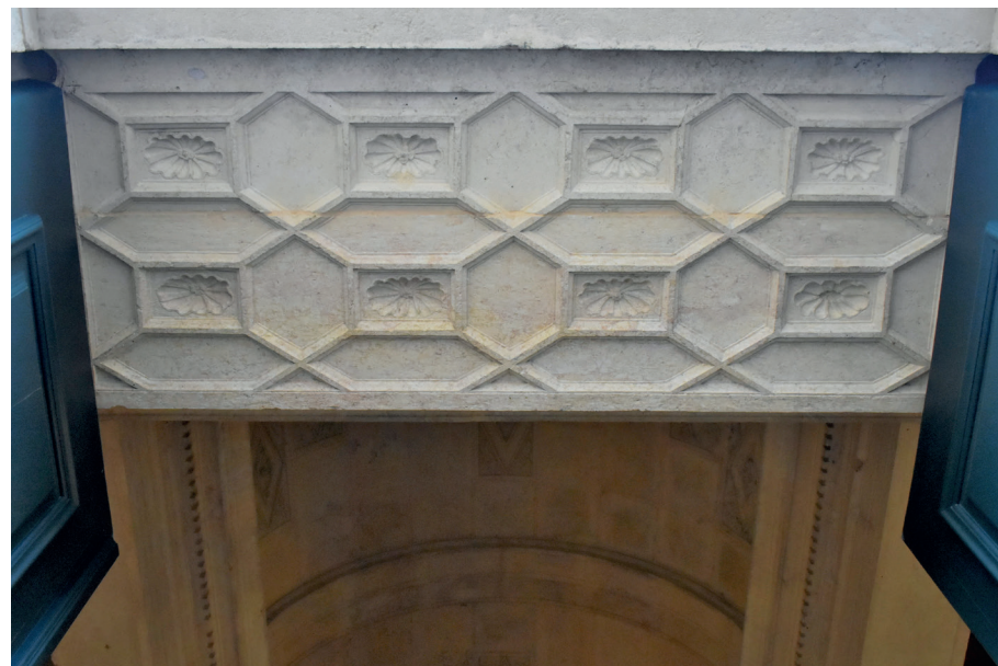
Img. 71 -Pormenor da entrada.
