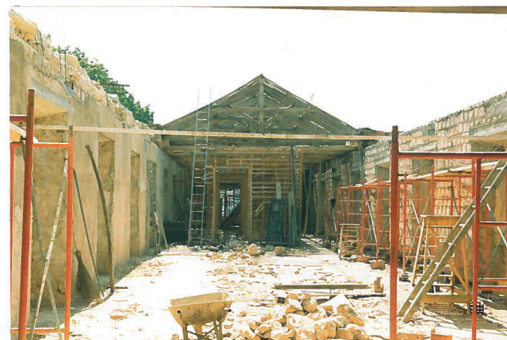
Figura 6, 7, 8, e 9 - Registos de intervenções realizadas no Convento de São Francisco nos anos 80 do século XX- Fornecidos pelo Arquivo Municipal de Tomar
