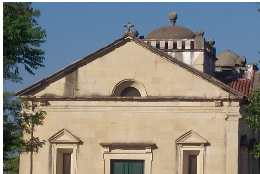
Img. 68-Destaque da abóbada na cobertura.
