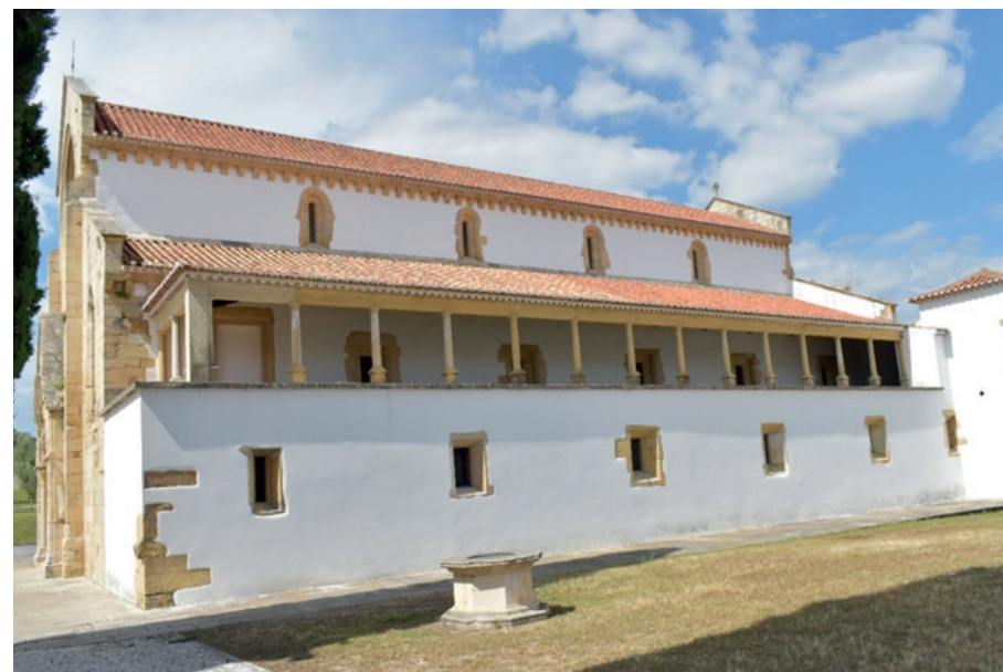
Img. 109-Vista da fachada Sul da Igreja de Sta. Maria.
