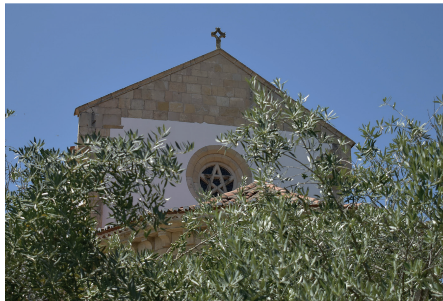
Img. 42-Óculo na fachada posterior da Igreja Gótica de Sta. Maria do Olival.
