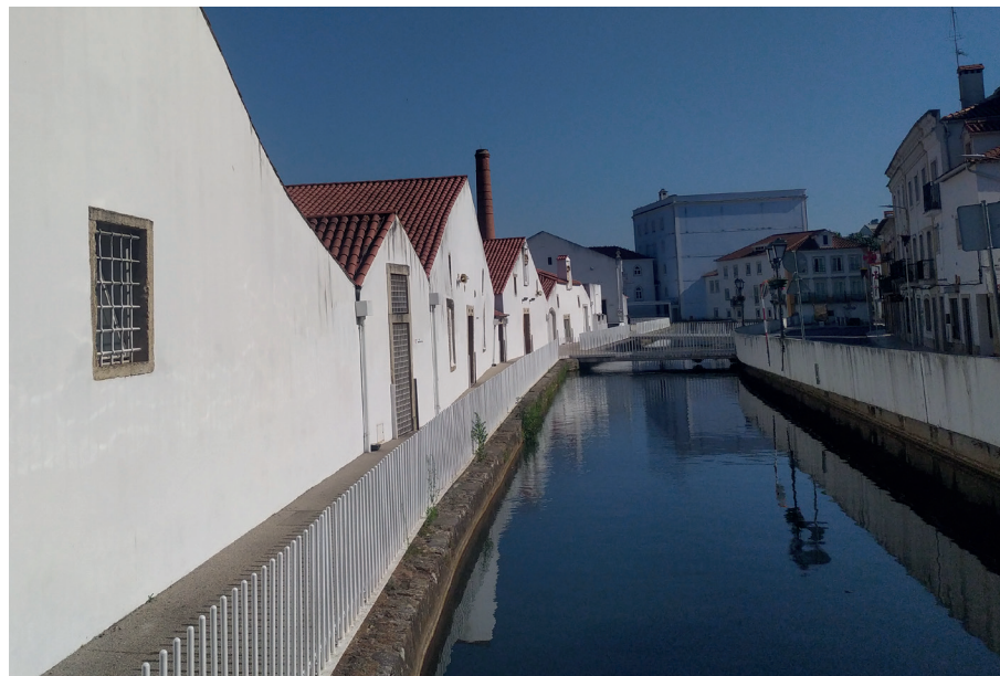
Img. 31-Levada que direcionava a água para as moagens, lagares, e central elétrica.
