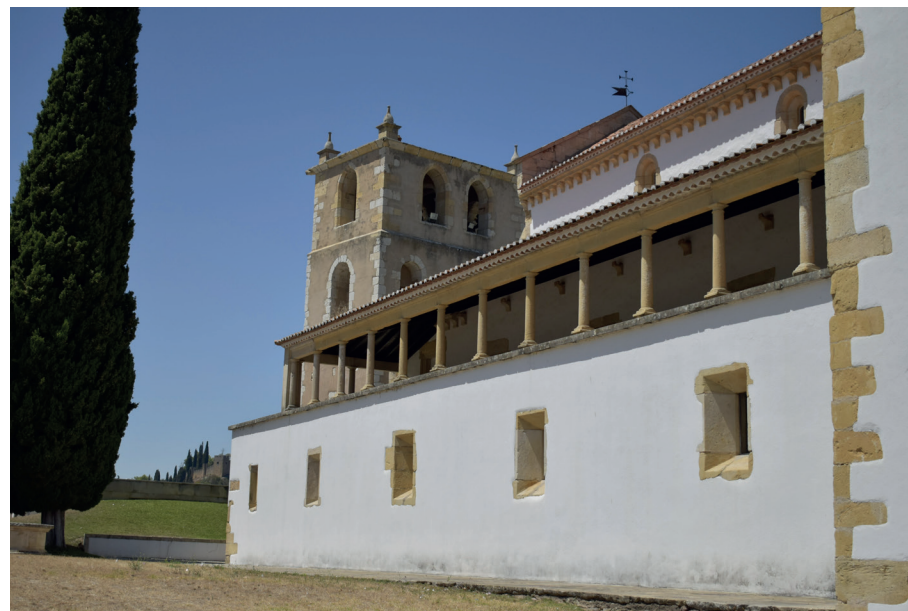
Img. 85-Fachada Sul e topo da torre da Igreja de Sta. Maria.
