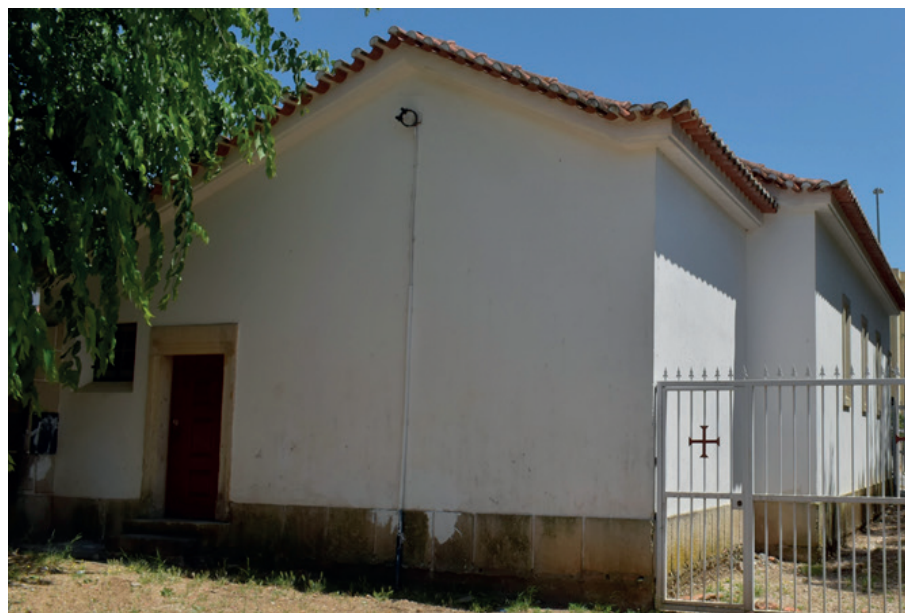
Img. 80-Fachada posterior e esquerda da Capela de Sto. António.
