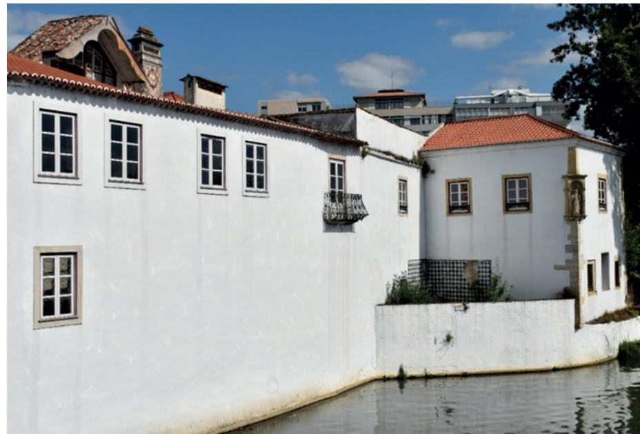
Img. 133-Fachada Poente do Convento de Sta. Iria.
