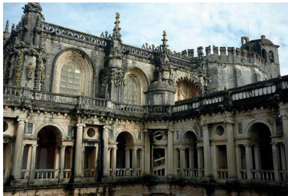
Img. 117-Vista do Claustro principal do Convento de Cristo.
