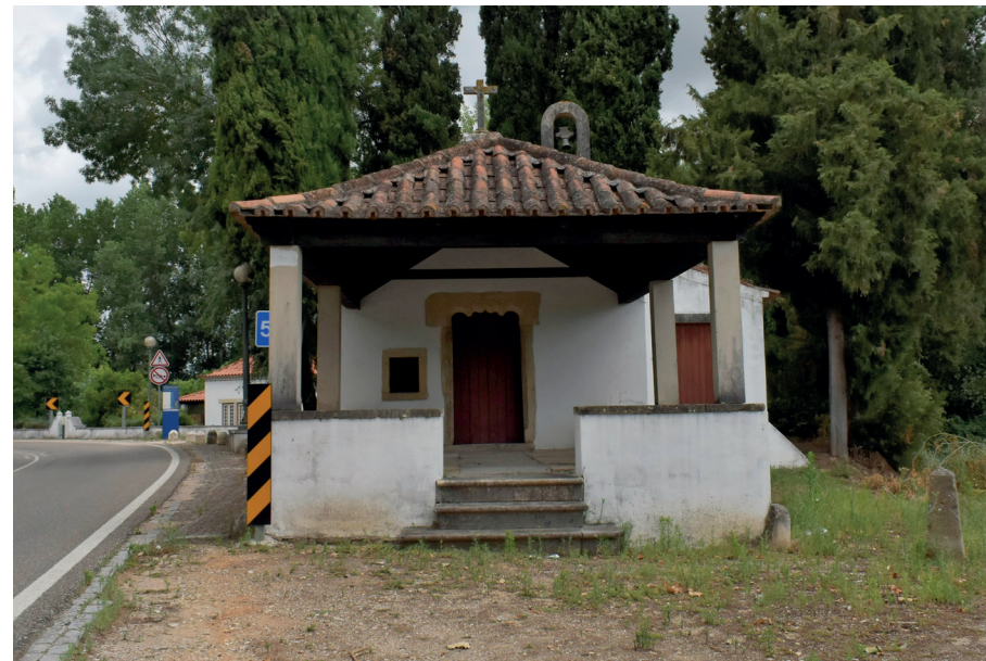
Img. 83-Fachada principal da Capela de S. Lourenço.
