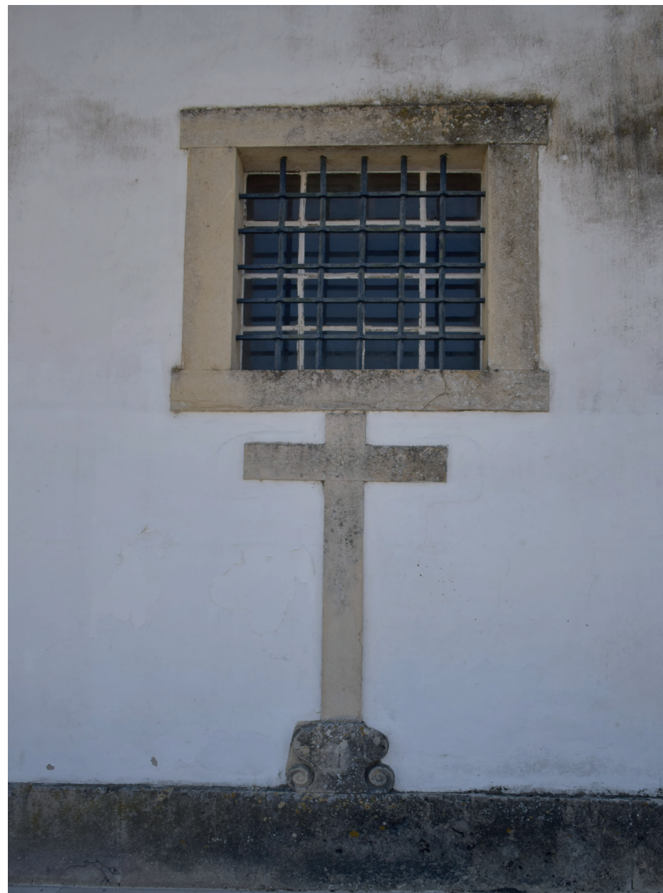
Img. 126-Pormenor da fachada principal do Convento de S. Francisco.
