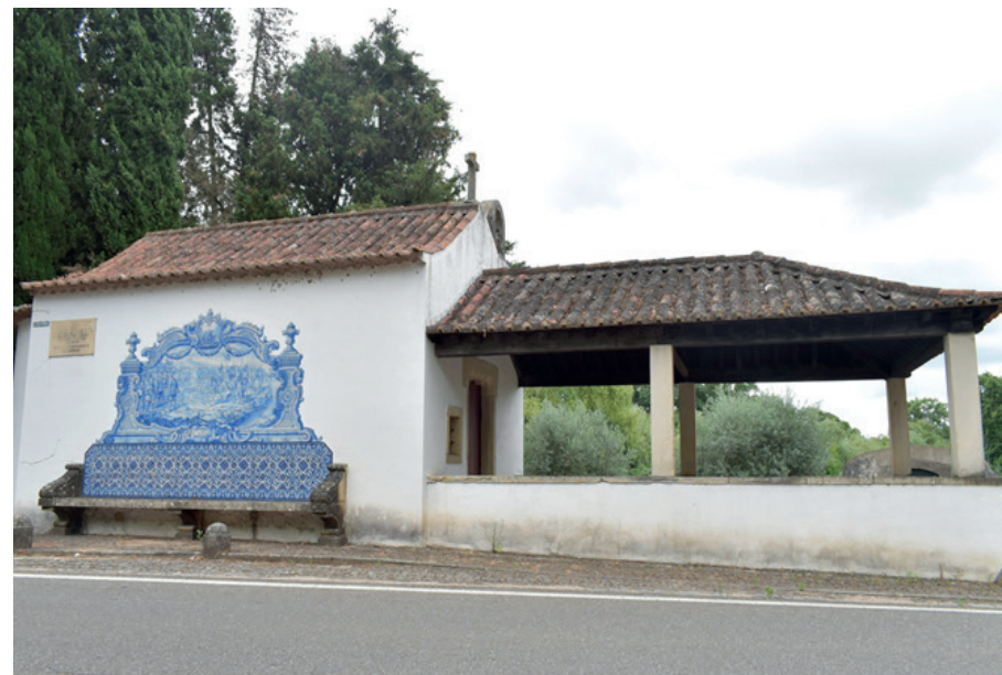
Img. 84-Fachada lateral esquerda da Capela de S. Lourenço.
