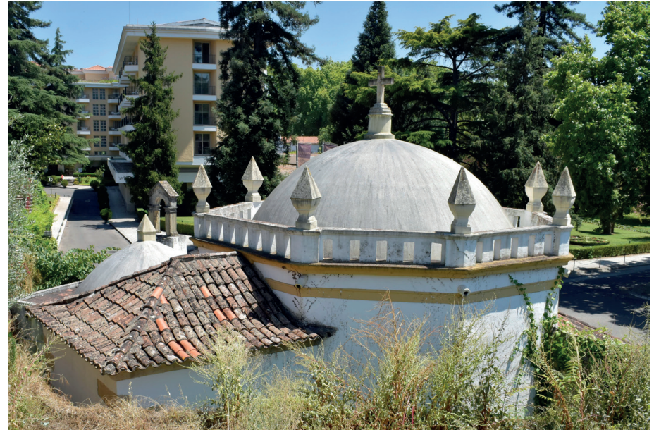
Img. 77-Coberturas da Capela de S. Gregório.
