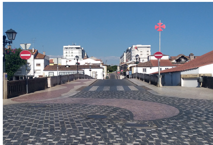
Img. 29-Eixo da “Ponte Velha”.
