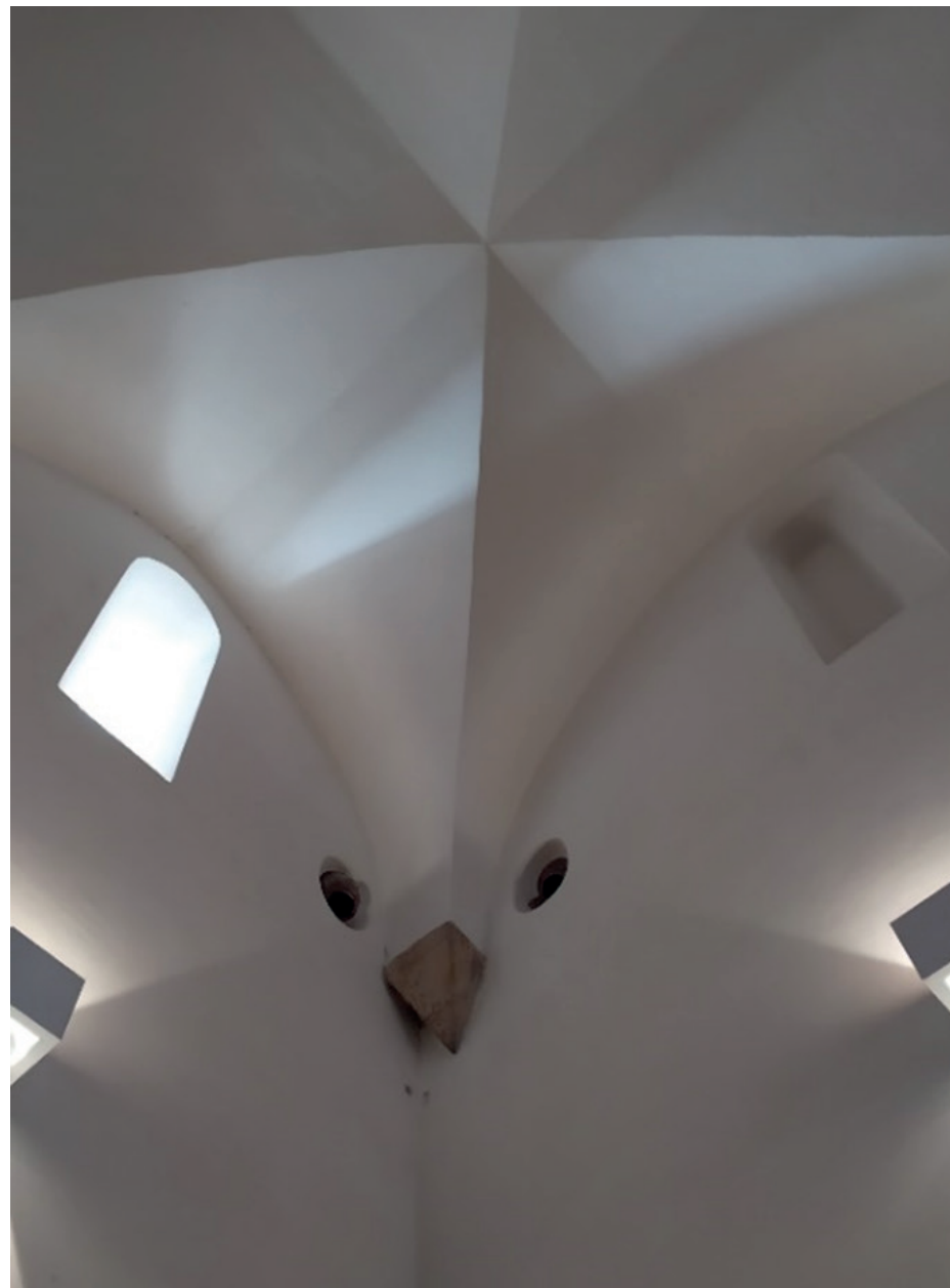
Img. 150-Sistema acústico da Sinagoga tomarense.
