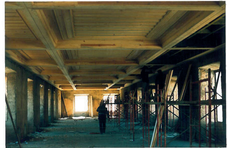
Figura 2,3 , 4 e 5 - Registos de intervenções realizadas no Convento de São Francisco nos anos 80 do século XX - Fornecidos pelo Arquivo Municipal de Tomar
