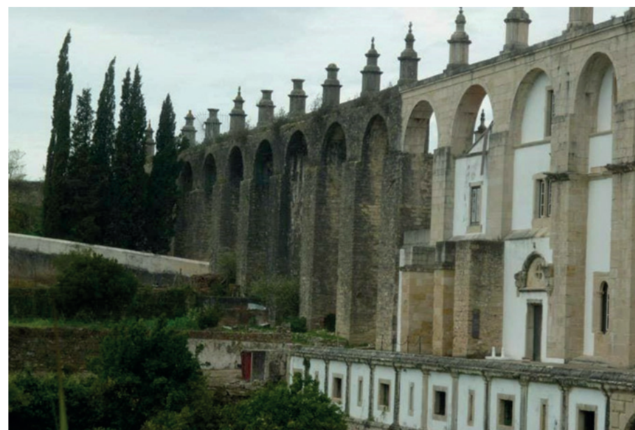
Img. 11-Junção do Aqueduto ao Convento de Cristo.
