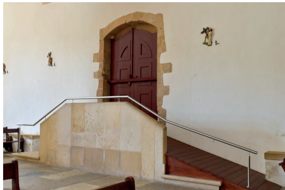
Img. 112-Enquadramento interior do Portal Norte da Igreja de Sta. Maria. 96
