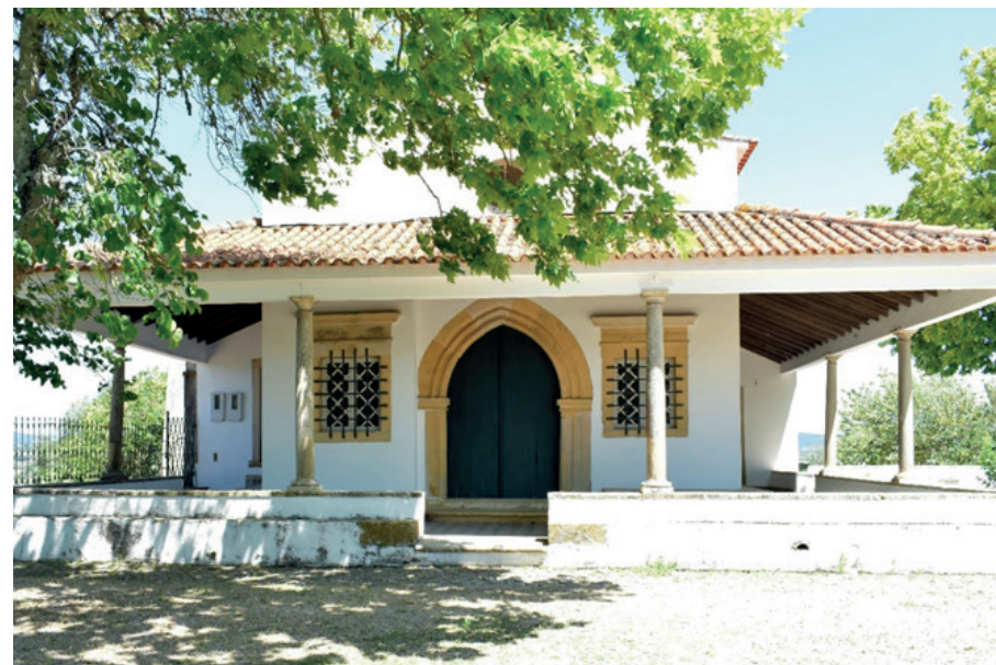
Img. 74-Fachada principal da Ermida de N. Sra. da Piedade.
