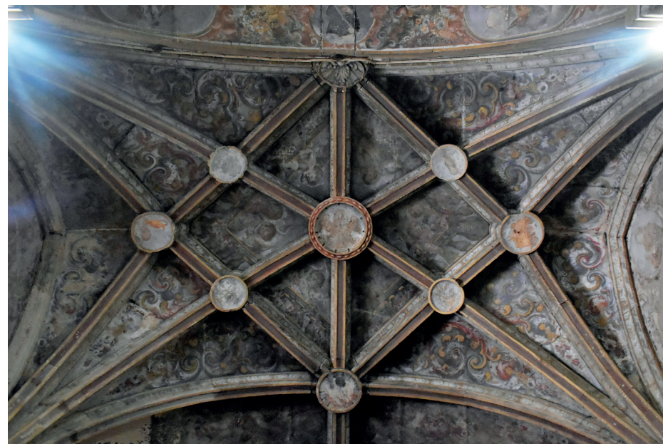
Img. 143-Teto da Capela-mor da Igreja de Sta. Iria.
