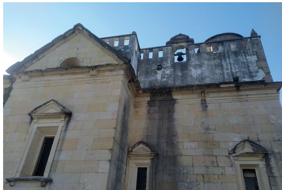
Img. 69-Destaque do terraço na cobertura.
