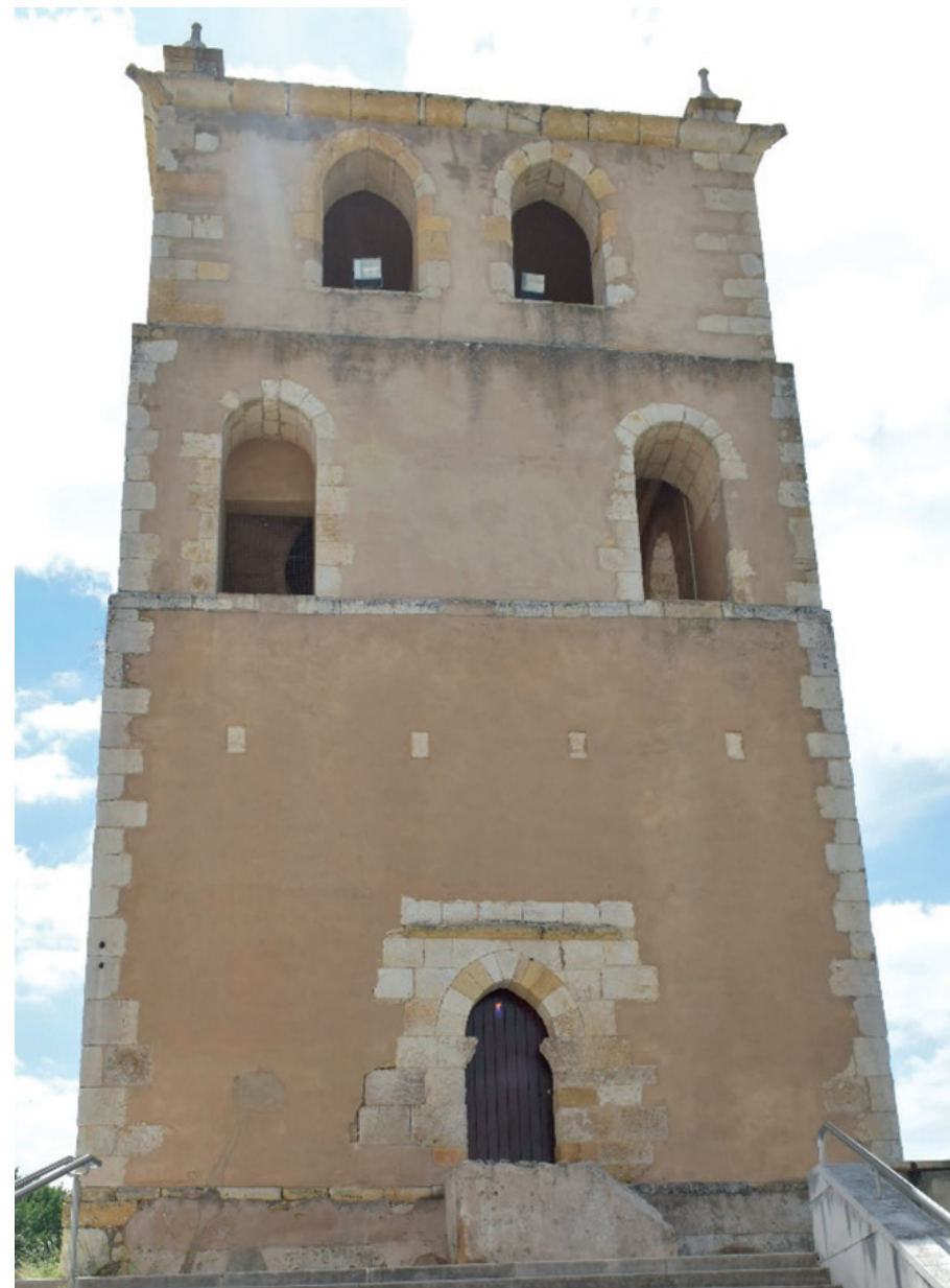
Img. 110-Torre sineira vista da entrada da Igreja de Sta. Maria.
