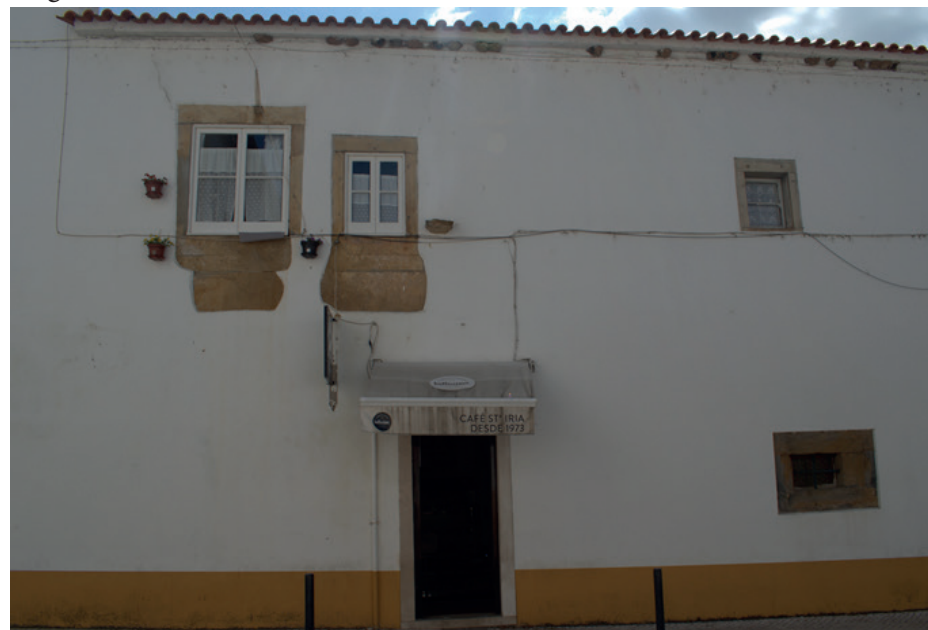
Img. 137-Entrada do Café Sta. Iria pela fachada Nascente do Convento.
