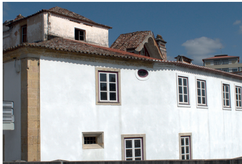
Img. 134-Fachada Poente do Convento de Sta. Iria.
