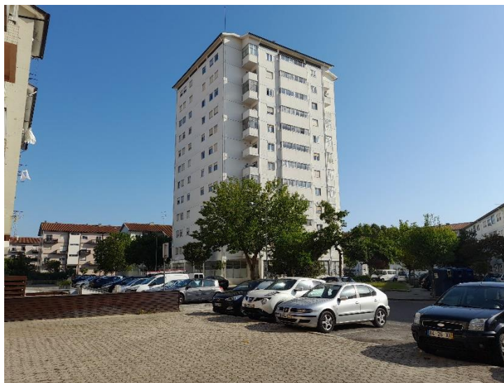
Figuras 12 – Fotografia da Torre na Urbanização da Quinta do Canha; Levantamento feito no terreno, 17 de março de 2022
