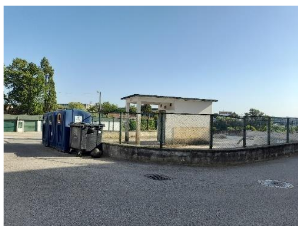
Figura 19 – Fotografia do Ponto de Extração de água, na Urbanização da Quinta do Canha;
