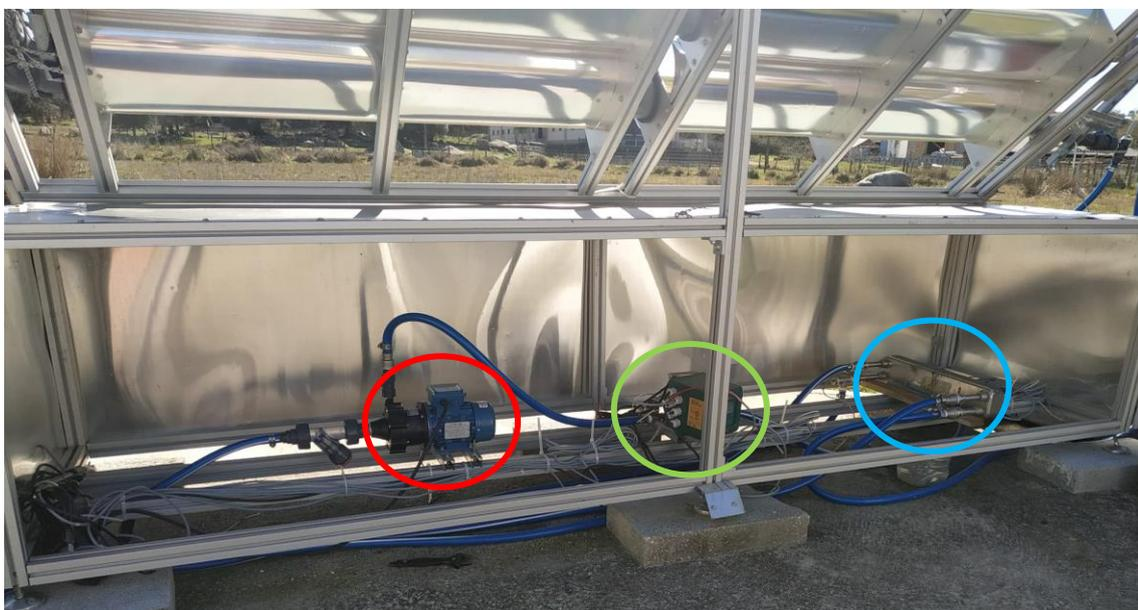
Figura 16 - Ligações estabelecidas no fotorreator (bomba de água – a vermelho, permutador – a azul, caudalímetro – a verde).
