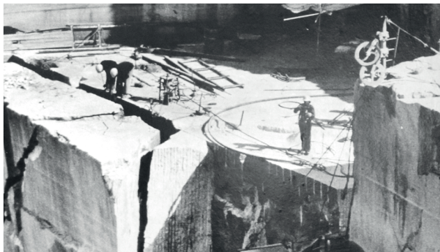
14. Pedreira de Vila Viçosa, Extração com recurso ao fio helicoidal, anos 60 | CECHAP | PHIM.
