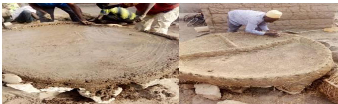
Figure 23: Crépi de la base d'un grenier à l'aide de zun ngurvun (pierre mamelle)
