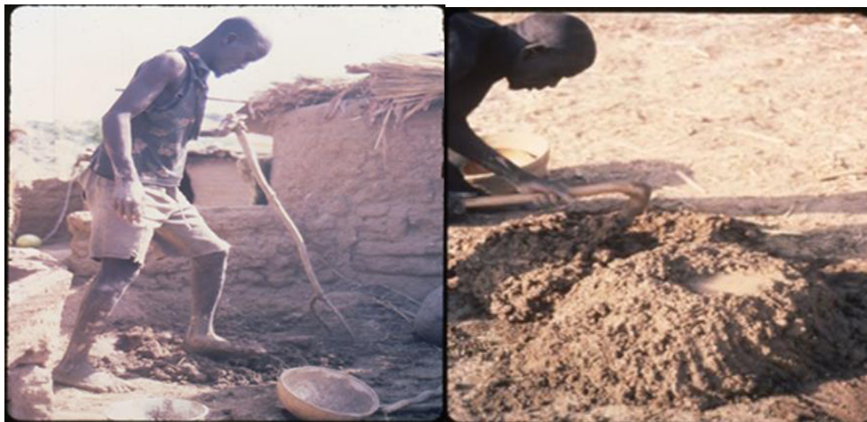
Figure 21: Pétrissage de la boue
