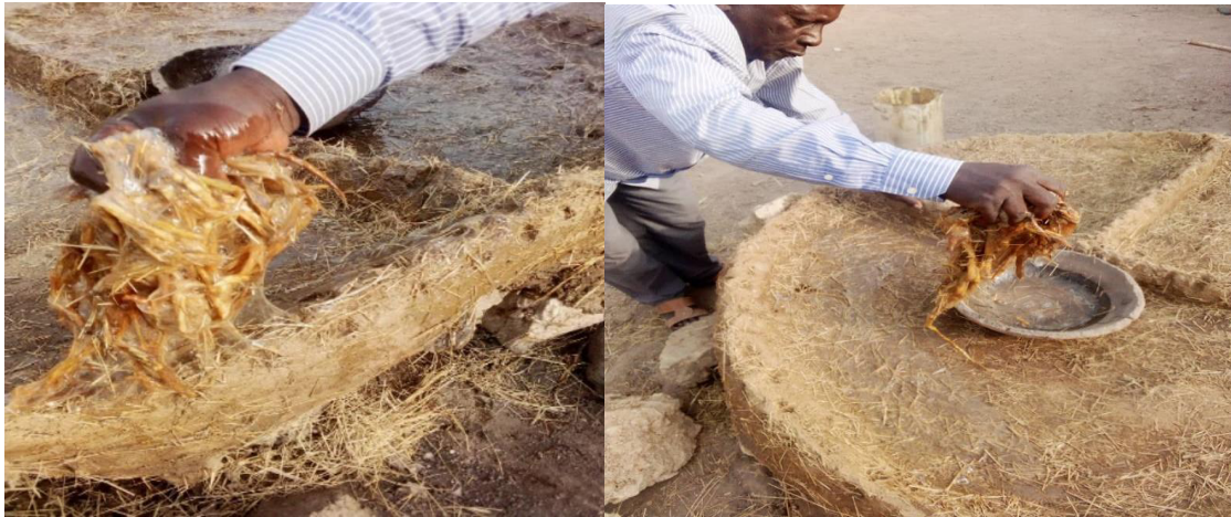
Figure 19: Crépi d'une base d'un grenier à l'aide de la sève de tsuzlub
