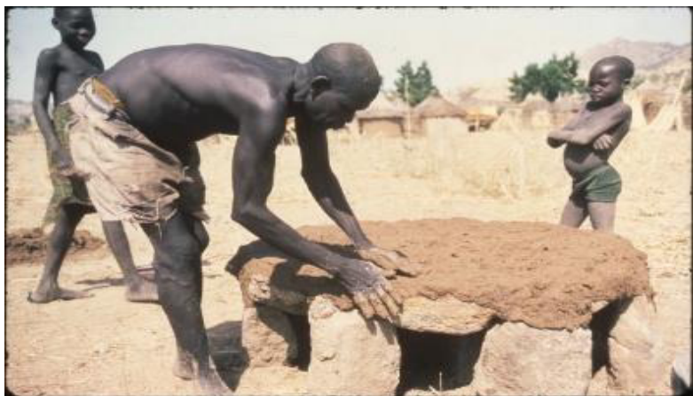
Figure 25: Début de construction d'un grenier et transmission des savoir-faire
