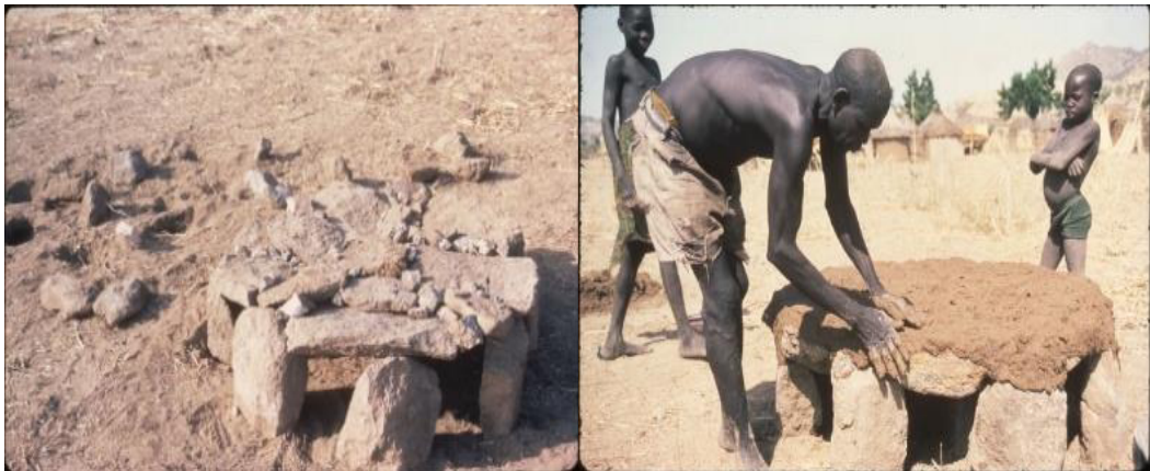
Figure 22: Début de construction d'une base d'un grenier
