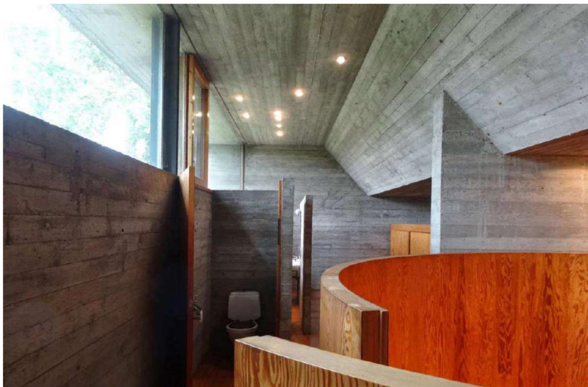
fig. 40 Vista da cozinha, com mesa fixa em betão e exaustor triangular também, que dá continuidade ao armário - Volume cilíndrico que define o quarto e que se projeta para o nível principal da casa - A casa de banho é um espaço estreito, entre a parede oeste e duas divisórias fina e baixas, também em betão - O quarto definido por um plano em madeira, bem fino e baixo
