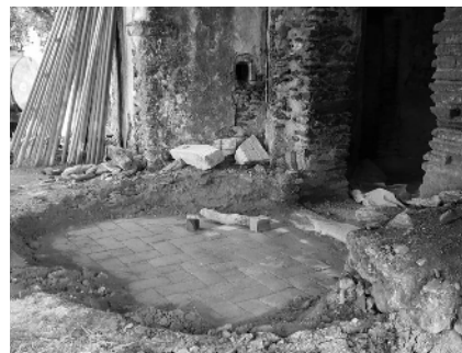
Fig. 124. Pavimento. Fotografia de Baixa Atelier de Arquitectura, 2018.
