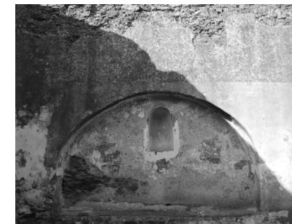
Fig. 207. Alçado interior esquerdo da Nave. Fotografia da autora, 2021.
