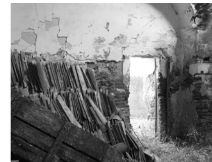
Fig. 188. Porta de acesso, a Este. Fotografia da autora, 2021.
