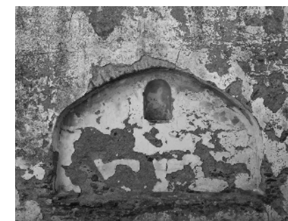
Fig. 208. Alçado interior direito da Nave. Fotografia da autora, 2021.
