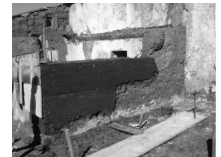
Fig. 153. Paredes da Sacristia em taipa. Fotografia de Ricardo Freixial, 2017.
