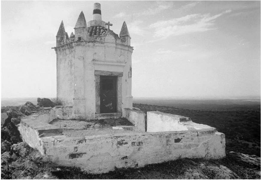
Figura 322. Ermida de São Pedro, antes de ser recuperada. Fotografia de DGPC (SIPA FOTO.00026524).
