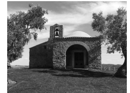
Fig. 128. Fachada Principal, a Noroeste. Fotografia de Nuno Cortes, 2021.
