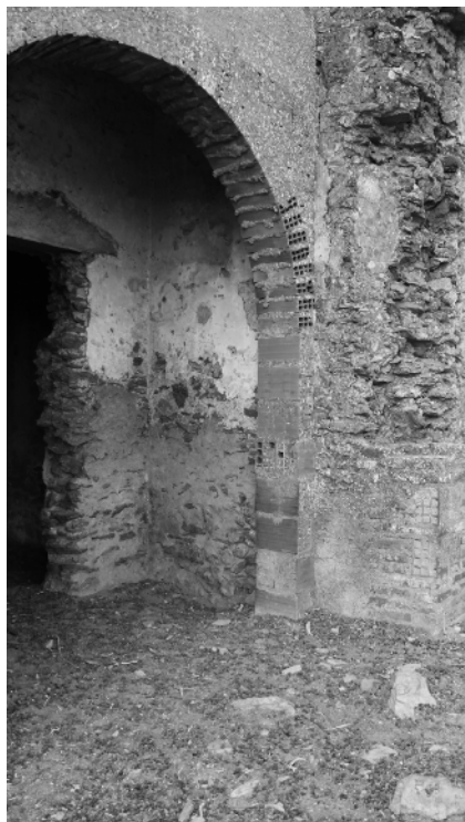
Fig. 248. Vão de acesso (à antiga Sacristia). Fotografia da autora, 2016.
