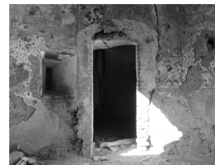
Fig. 116. Vão de acesso à Sacristia. Fotografia da autora, 2016.
