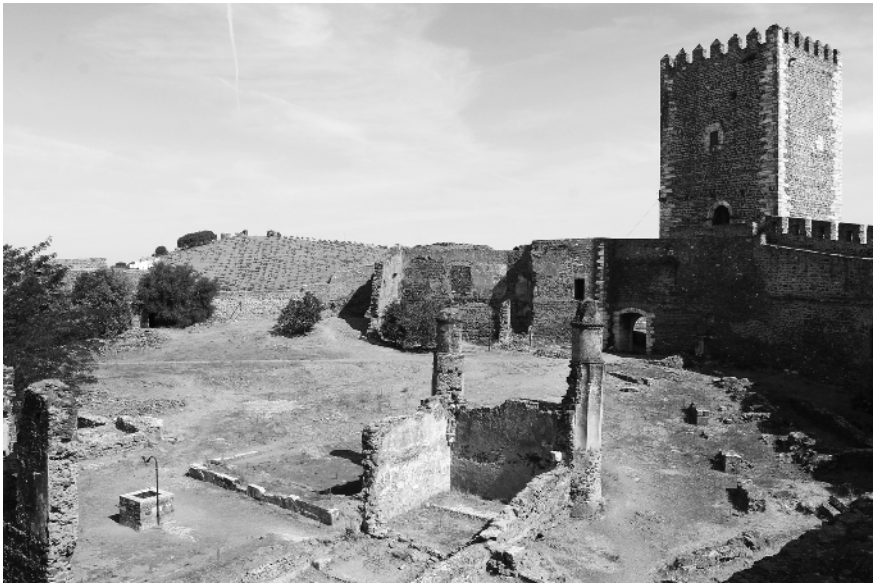
Figura 047. Castelo de Portel, vista a partir do seu interior. Fotografia da autora.
