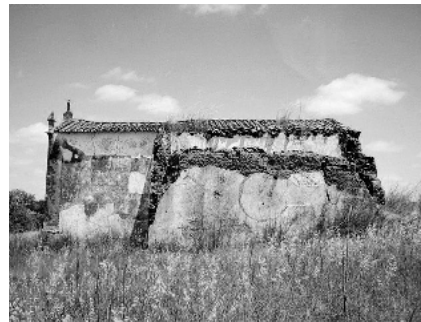
Fig. 145. Alçado Lateral Direito. Fotografia de DGPC (SIPA FOTO.00026498), 1999.
