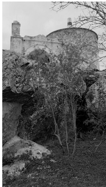
Fig. 314. Alçado Lateral Direito. Fotografia de DGPC (SIPA FOTO.00145826), 1999.
