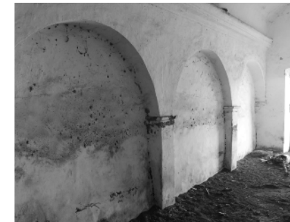
Fig. 275. Arcos cegos nas paredes laterais. Fotografia da autora, 2021.
