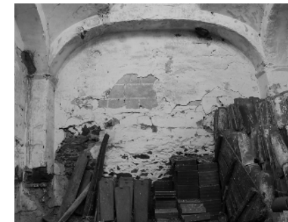
Fig. 190. Parede fundeira da Capela-mor. Fotografia da autora, 2021.
