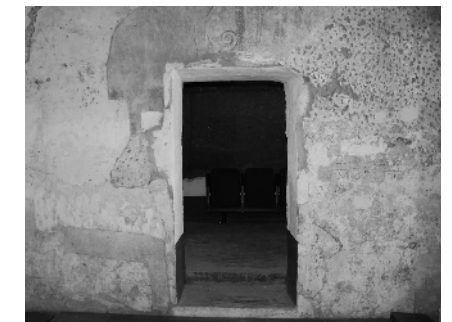
Fig. 167. Vão de acesso à Sacristia. Fotografia da autora, 2021.
