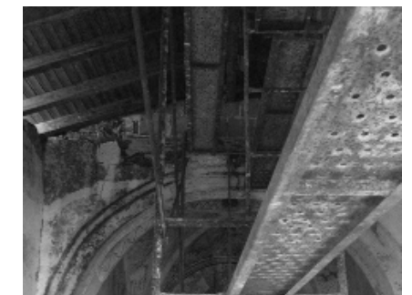
Fig. 155. Estrutura de madeira visível. Fotografia de Ricardo Freixial, 2017.
