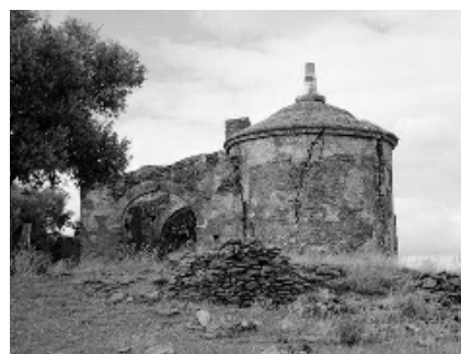
Fig. 109. Alçado Lateral Direito. Fotografia de DGPC (SIPA FOTO.00026510), 1999.
