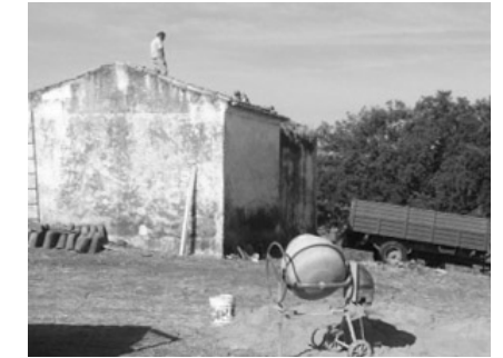
Fig. 149. Colocação e reparação do telhado. Fotografia de Ricardo Freixial, 2017.
