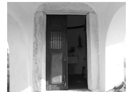
Fig. 320. Vão de acesso à Nave. Fotografia da autora, 2021.
