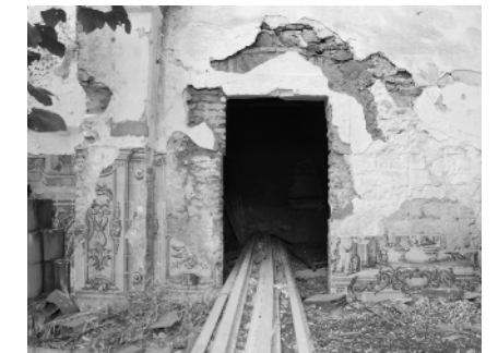
Fig. 191. Vão de acesso à Sacristia. Fotografia da autora, 2021.
