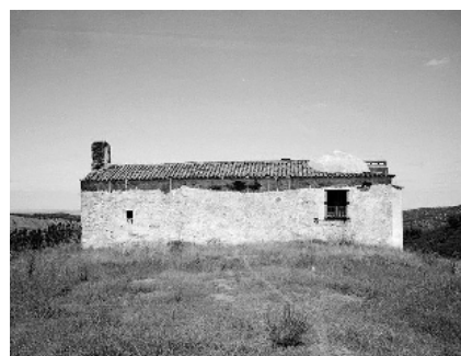
Fig. 224. Alçado Lateral Direito. Fotografia de DGPC (SIPA FOTO.00038122), 1999.
