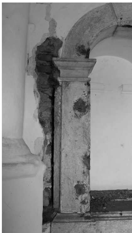
Fig. 330. Detalhe do interior. Fotografia da autora, 2016.
