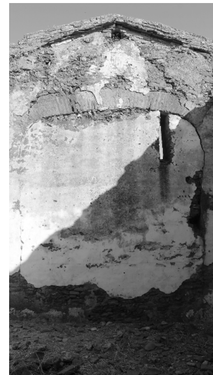
Fig. 206. Parede fundeira da Nave. Fotografia da autora, 2021.
