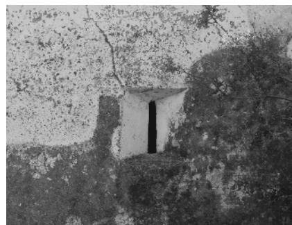
Fig. 272. Fachada lateral, pequena fresta. Fotografia da autora, 2016.
