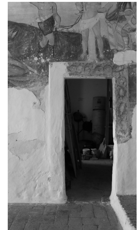
Fig. 300. Vão de acesso à Sacristia. Fotografia da autora, 2021.
