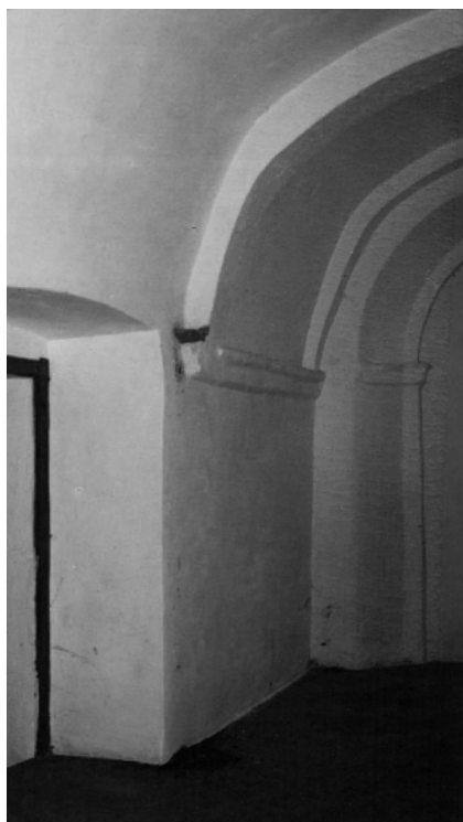
Fig. 225. Interior da Ermida. Arquivo Municipal de Portel, 1999.
