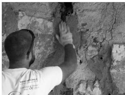
Fig. 125. Reparação e consolidação. Fotografia de Baixa Atelier de Arquitectura, 2018.
