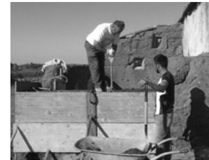
Fig. 150. Enchimento dos taipais de madeira. Fotografia de Ricardo Freixial, 2017.
