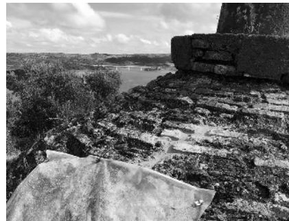
Fig. 121. Cobertura. Fotografia de Baixa Atelier de Arquitectura, 2018.
