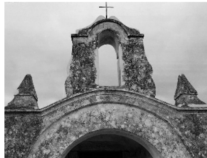
Fig. 311. Campanário, sem sino. Fotografia de DGPC (SIPA FOTO.00145816), 1999.
