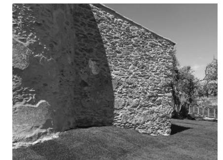
Fig. 129. Fachada Posterior, a Sudeste. Fotografia de Nuno Cortes, 2021.
