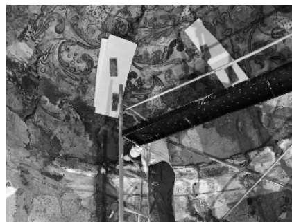
Fig. 126. Cúpula da Nave. Fotografia de Baixa Atelier de Arquitectura, 2018.
