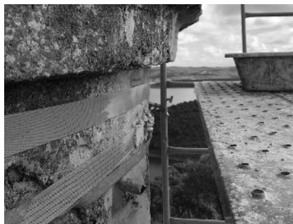
Fig. 123. Consolidação das paredes exteriores. Fotografia de Baixa Atelier de Arquitectura, 2018.
