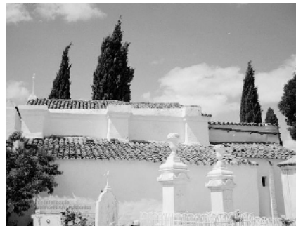
Fig. 292. Alçado Lateral Direito. Fotografia de DGPC (SIPA FOTO.00026535), 1999.
