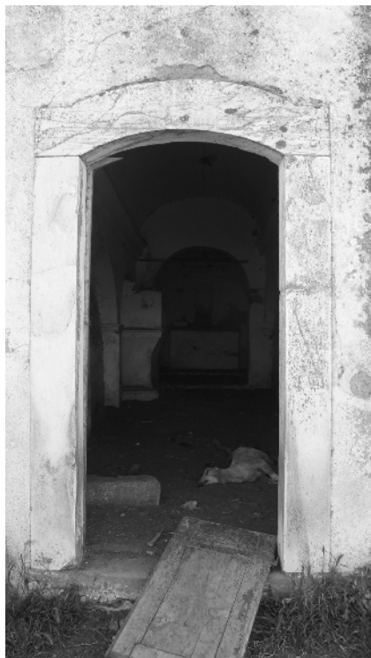
Fig. 270. Porta de acesso ao interior. Fotografia da autora, 2016.
