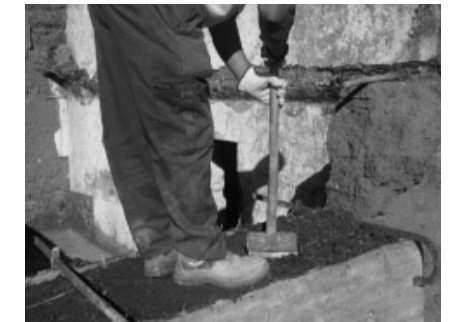
Fig. 151. Compactação da terra. Fotografia de Ricardo Freixial, 2017.
