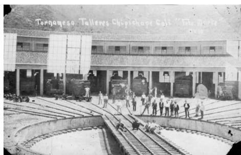
Fig. 56 : Auteur non identifié, photographie « Ateliers ferroviaires à Chipichape, plaque tournante », 1930. Source : AFFVC
