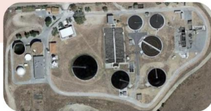
Estação de Tratamento de Águas Residuais (Odemira)
