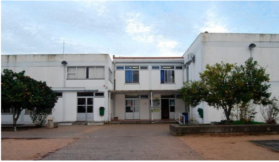
Figura 27: Fachada da Escola EB1 do Frei Aleixo.
