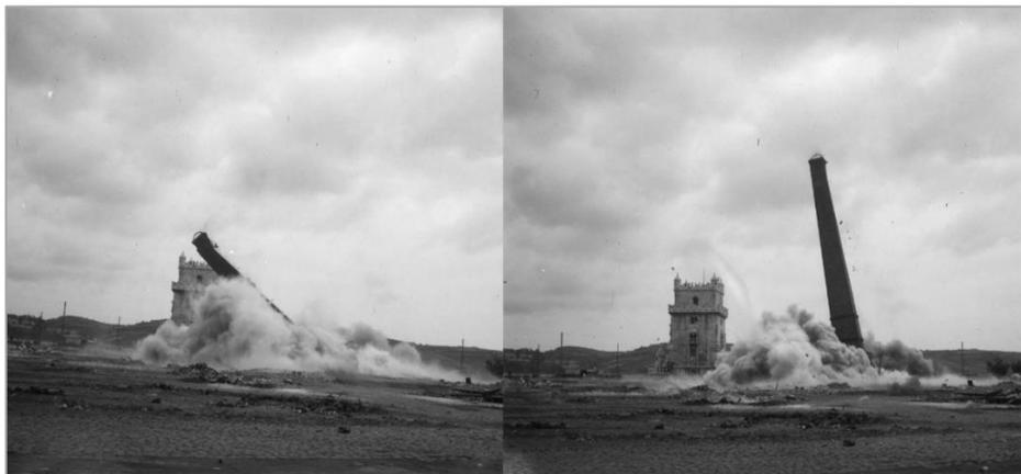
Figura 22 Fábrica de Gás de Belém, implosão da segunda chaminé, 1950. Fonte AML.
