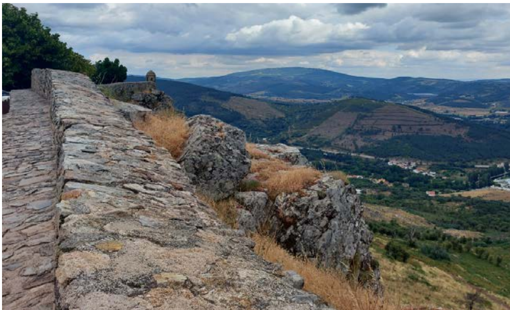
Fotografia 26 Penhasco rochoso em torno dos panos de muralha da fortificação
