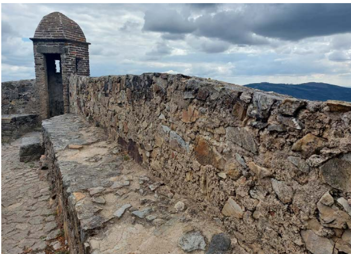
Fotografia 27 Guarita pertencente ao pano de muralha direito da fortificação
