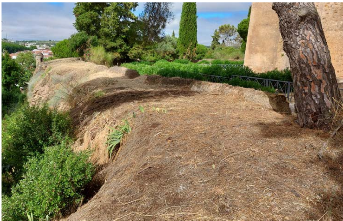
Fotografia 17 Terrapleno do baluarte situado na zona esquerda da defesa
