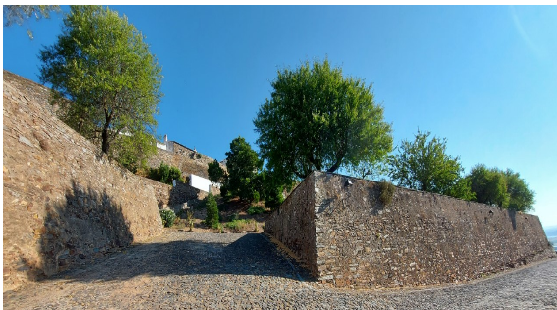
Fotografia 10 Reduto e parte da cortina da zona esquerda da fortificação
