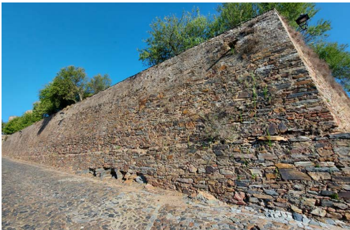
Fotografia 9 Cortina do reduto esquerdo a partir da entrada na fortificação
