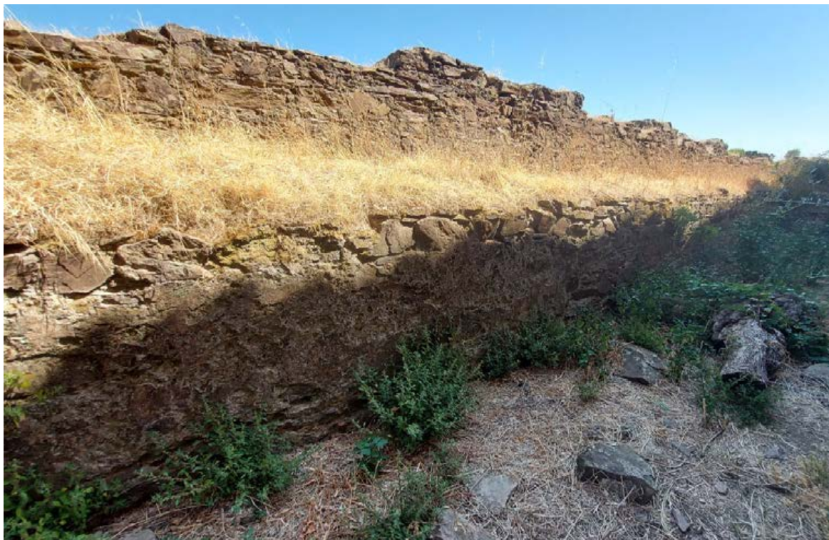
Fotografia 16 Pano de muralha completamente aterrado na zona traseira da fortificação
