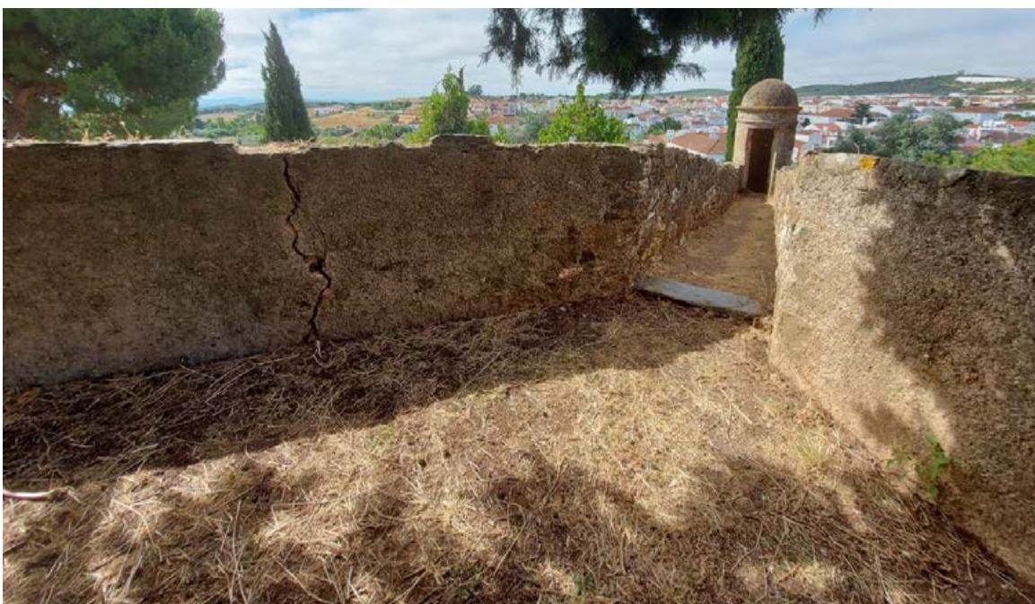
Fotografia 19 Pano de muralha da guarita do baluarte situado na zona esquerda da defesa (roto)
