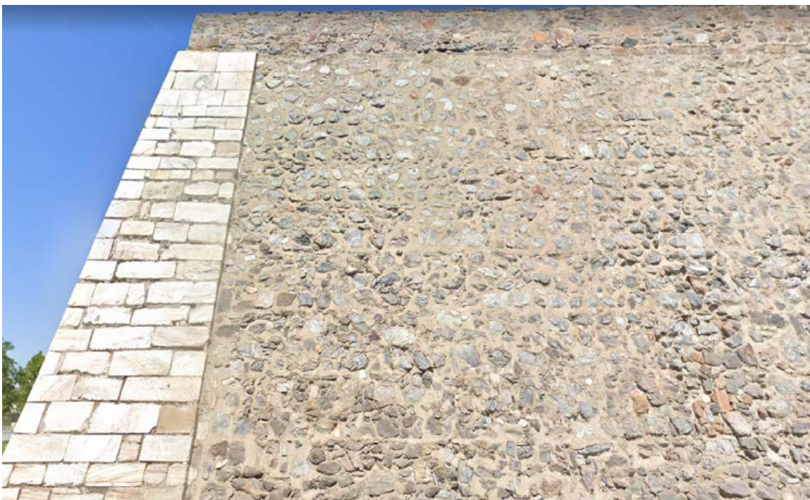
Fotografia 11 Baluarte da Muralha Nova (ou dos Cágados ou das Lavadeiras)
