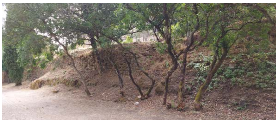
Fotografia 13 Pano de muralha abaluartada aterrada junto à entrada principal da defesa (vista por dentro)
