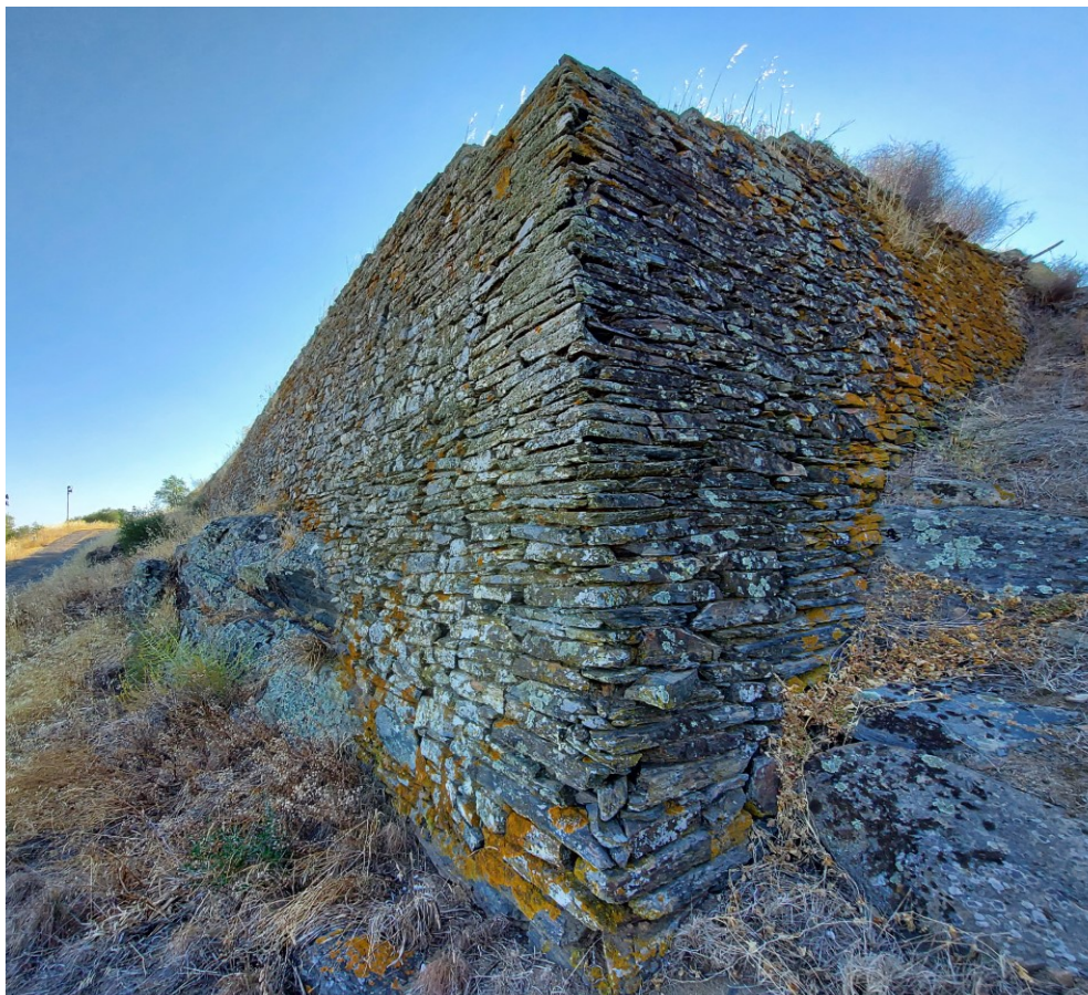
Fotografia 23 Extremo de baluarte na zona lateral esquerda da fortificação
