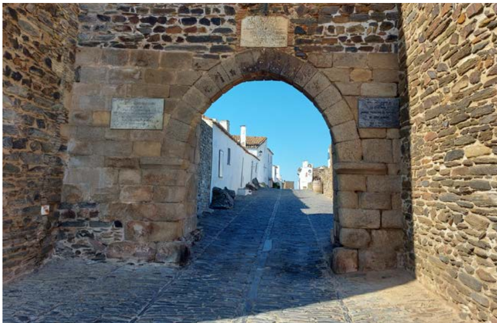
Fotografia 41 Antiga Porta da Vila que servia de acesso principal ao interior da defesa (exterior)
