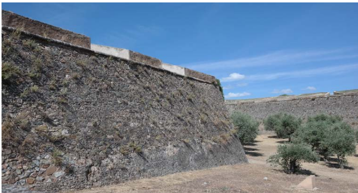
Fotografia 38 Defesa situada no lado direito da Porta exterior da Esquina
