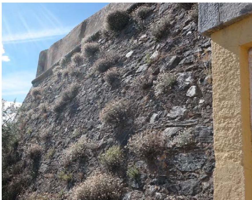
Fotografia 39 Defesa situada no lado esquerdo da Porta exterior da Esquina
