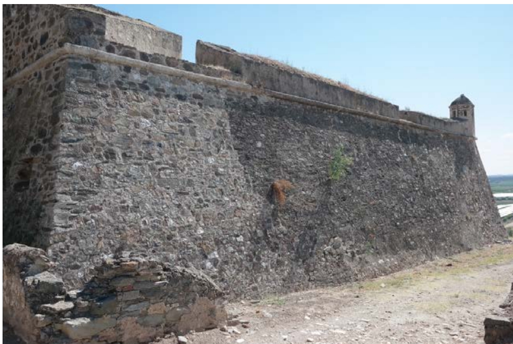
Fotografia 17 Baluarte situado no lado direito da fortificação
