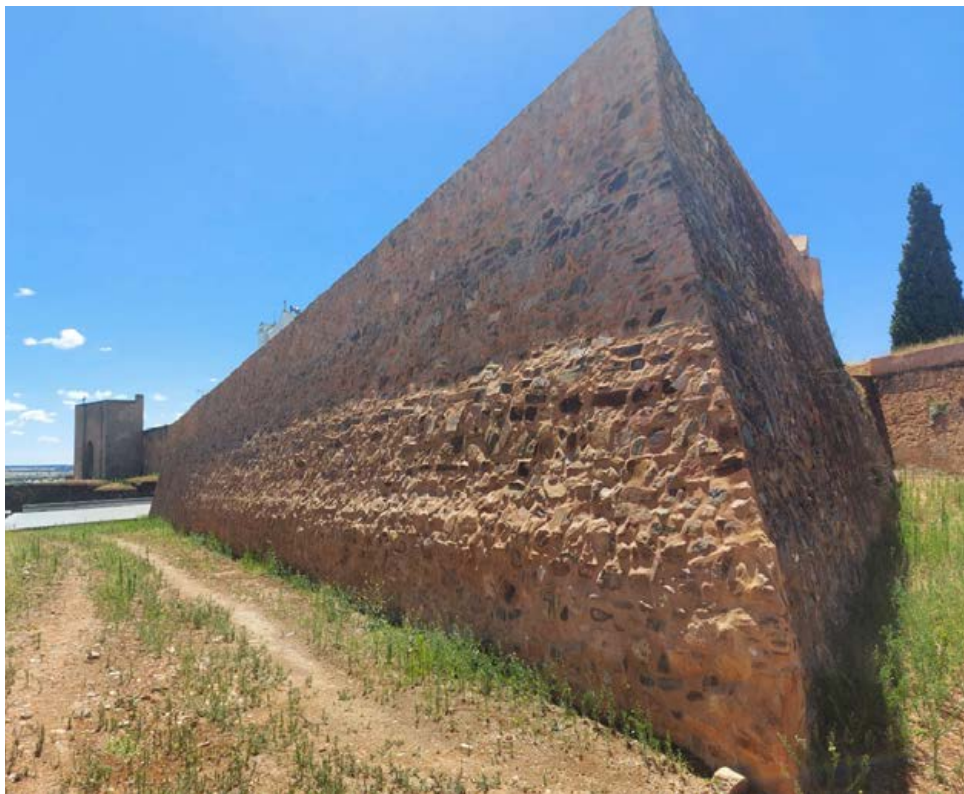
Fotografia 11 Parte frontal de baluarte na zona lateral direita da fortificação
