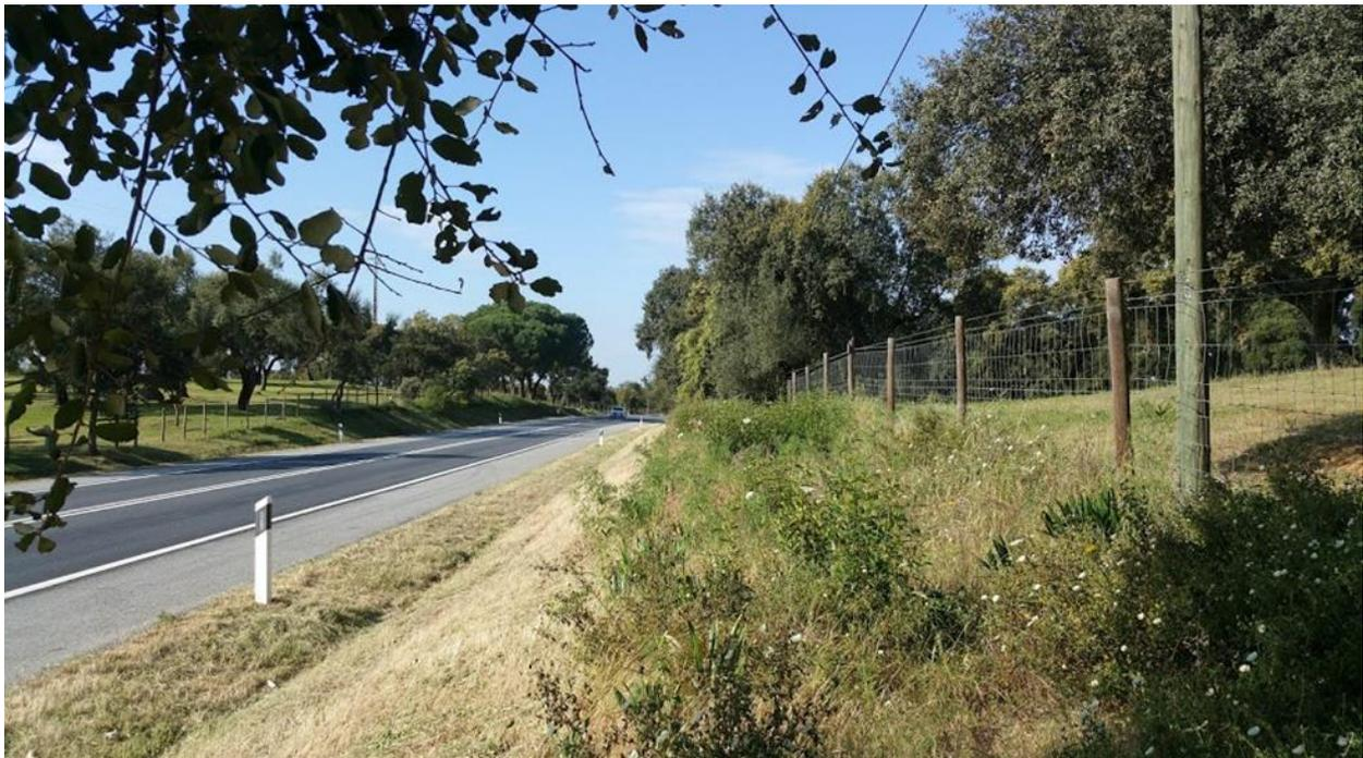
Figura 16 – Exemplo de faixa marginal de estrada com vegetação cortada ao nível do solo nos 3 m adjacentes ao asfalto e ilhas de matos afastadas do asfalto. (Foto: António Mira)
