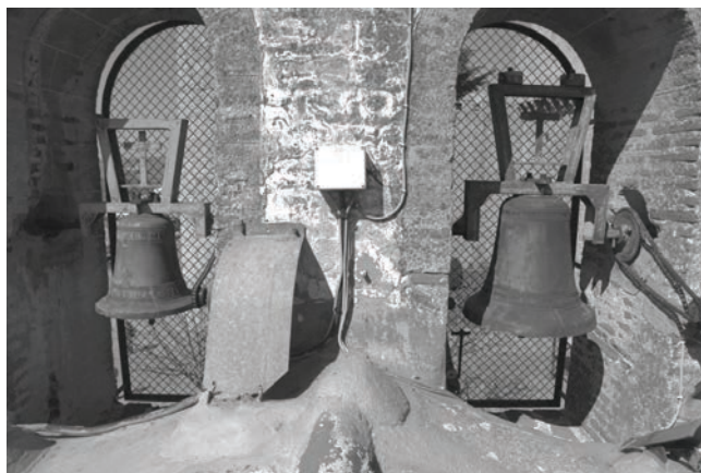
Fig. 16 – Campanas con yugo de hierro y mecanizadas de la espadaña del convento de las Concepcionistas Franciscanas. Foto del autor
