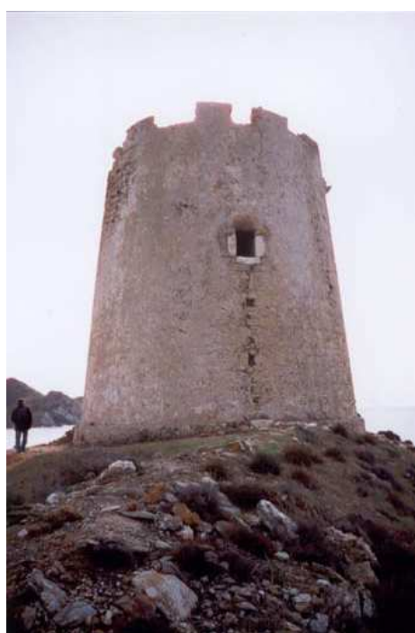
Fig. 1- Torre di Piscinni
