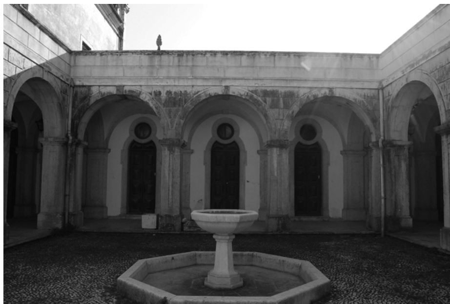
Fig. 101: Claustro pequeno visto do terraço (superior esquerda), corredor de acesso do pátio da igreja ao claustro pequeno (superior esquerda) e ala Sul do claustro pequeno, onde se localizavam três capelas (em baixo).
