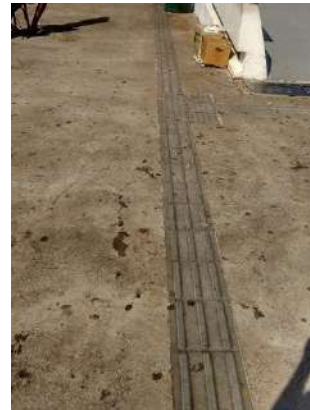
Figura 11 | Piso tátil na parte externa do Museu. Fonte: Elaboração própria, 2018.
