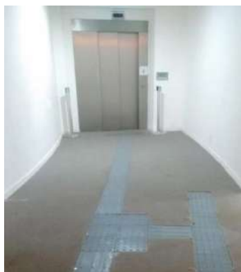
Figura 14 | Elevador que permite acesso aos banheiros. Fonte: Elaboração própria, 2018.
